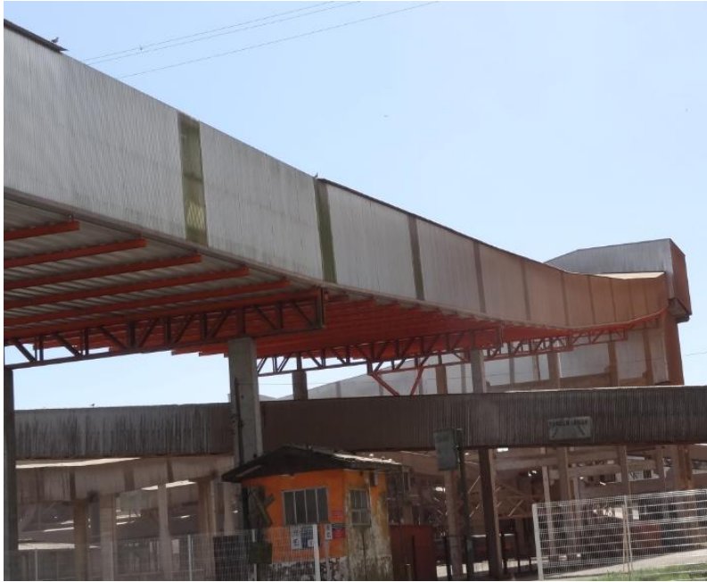
Figura 34. Esteira de movimentação de carga em fase de construção, em Paranaguá. Fonte: ESALQ-LOG (2013).
