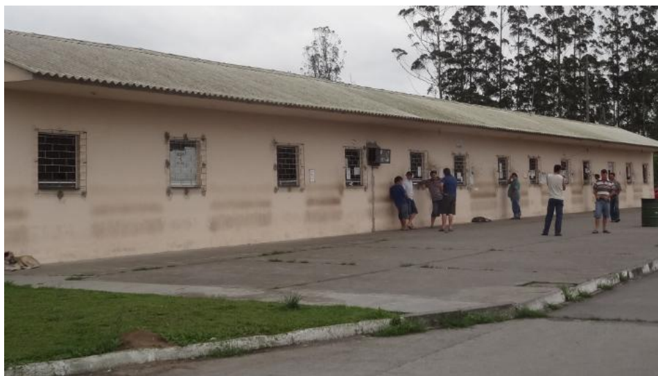
Figura 18. Guichês das operadoras portuárias presentes no pátio de triagem. Fonte: ESALQ-LOG (2013).
