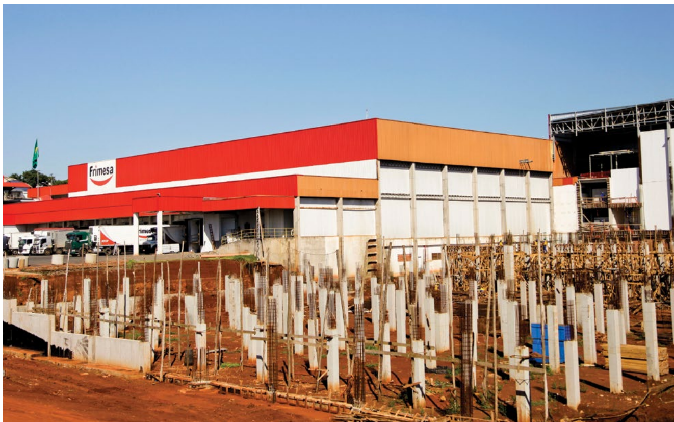
Expansão: Unidade da Frimesa em Medianeira iniciou em 2013 obras para aumentar a efetividade logística
