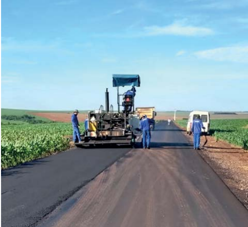
Mobilização dos produtores garante acesso asfaltado a propriedades rurais no Oeste do Paraná
