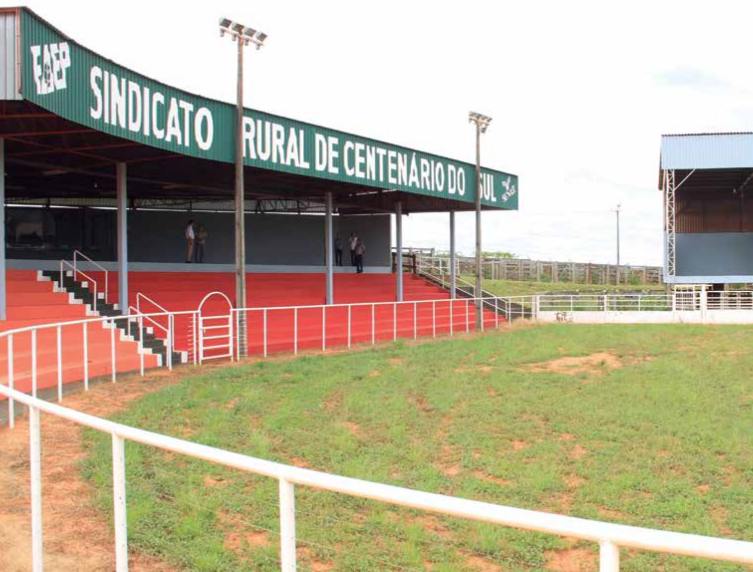
Locação das estruturas da sede campestre também gera renda para o sindicato
