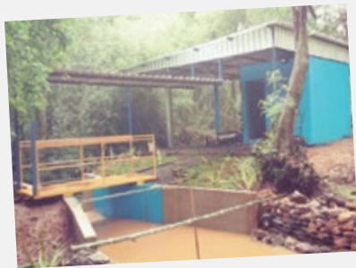
Calha Parshal foi instalada em arroios
