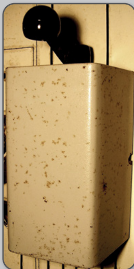
Figura 33 – Chave rotativa liga-desliga.
