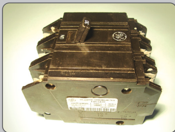
Figura 26 – Disjuntor termomagnético tripolar.
