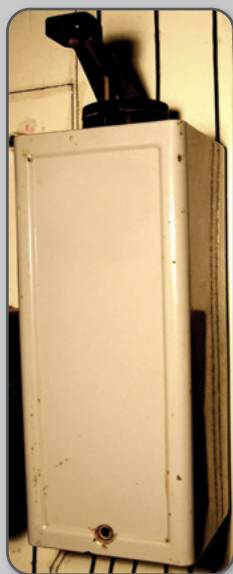
Figura 35 – Chave rotativa estrela-triângulo.
