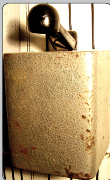
Figura 36 – Chave rotativa reversora.
