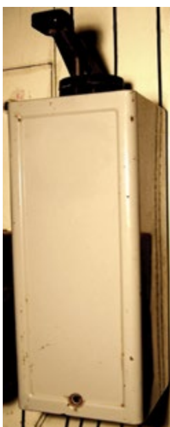
Figura 35 – Chave rotativa estrela-triângulo.
