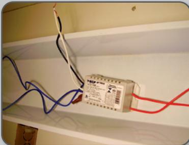
**44** Reator eletrônico instalado
