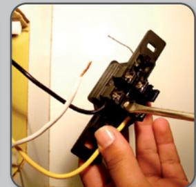
**20** Fixar o diodo nos 2 parafusos do meio do interruptor.
