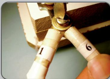
**1** Juntar os terminais 1 e 6 e fixá-los no terminal da esquerda na saída da chave.
