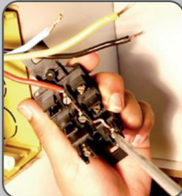
**20** Fixar o fio vermelho no parafuso da direita da tomada.
