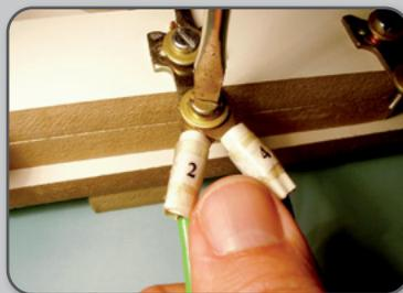
**2** Juntar os terminais 2 e 4 e fixá-los no terminal do meio na saída da chave.
