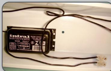
**38** Fios instalados no conector.
