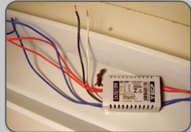
**9** Reator eletrônico instalado.
