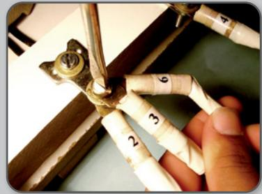
**3** Juntar os terminais 2, 3 e 6 e fixá-los no terminal do meio na saída da chave (sem linha).
