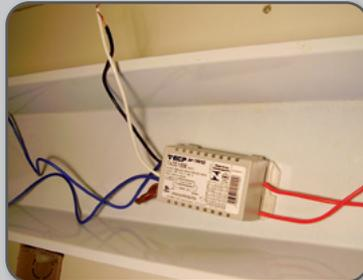
**32** Reator eletrônico instalado.
