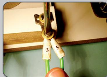
**3** Juntar os terminais 3 e 5 e fixá-los no terminal da direita na saída da chave.
