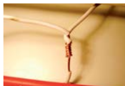
40. Fio branco fixado.
