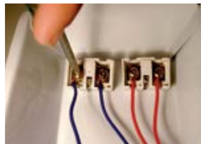
31. Fixar os fios azuis do reator no soquete oposto.
