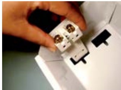
33. Introduzir o primeiro soquete na calha.
