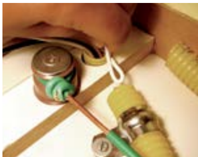
Figura 95 – Instalando uma lâmpada com dois interruptores de uma tecla (paralelos).
