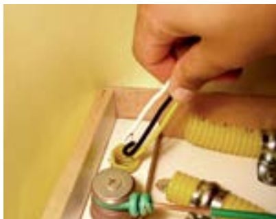
Figura 95 – Instalando uma lâmpada com dois interruptores de uma tecla (paralelos).
