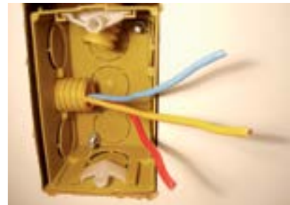
18. Caixa da segunda segunda tomada com fios.
