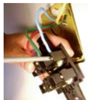
19. Fixar o fio azul no parafuso superior direito da tomada.
