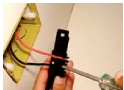
15. Fixar fios no interruptor.
