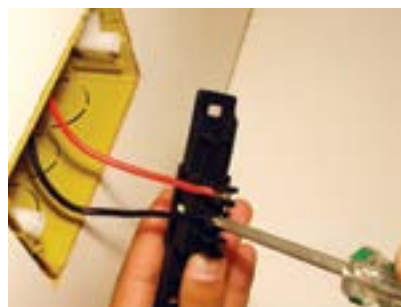
12. Fixar fios no interruptor.
