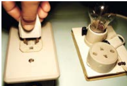
Figura 52 – Conectando o pino da lâmpada de prova a uma tomada energizada.
