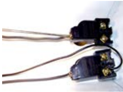
43. Fixar fio no porta starter da segunda lâmpada.
