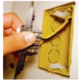
28. Alojjar interruptor na caixa.
