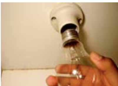
24. Colocar segunda lâmpada 127V x 40W.
