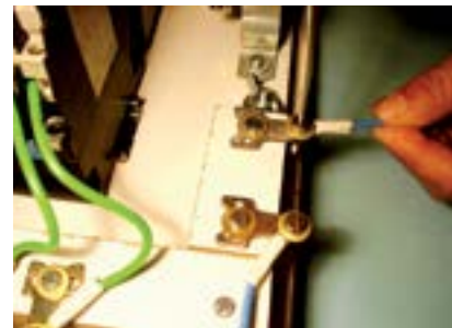
27. Fixar fio azul no outro terminal lateral.
