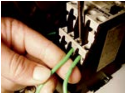
7. Fixar fio no L2 do contactor.
