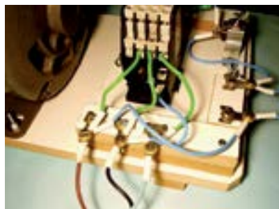
32. Contactor instalado (entrada).
