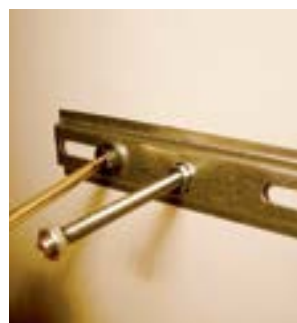
35. Fixar suporte com dois parafusos, arruelas e porcas.
