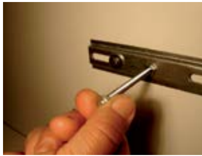
48. Retirar a porca da ponta do parafuso.
