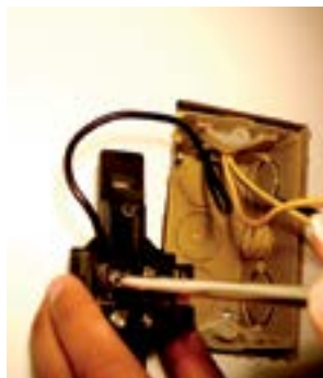
53. Fixar fio preto no parafuso de cima do interruptor.
