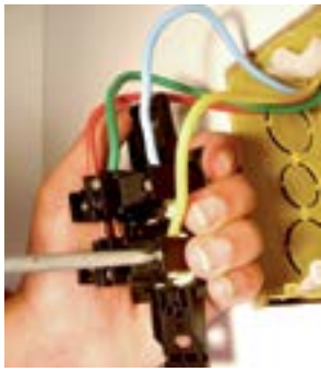
20. Fixar o fio amarelo no parafuso inferior direito da tomada.
