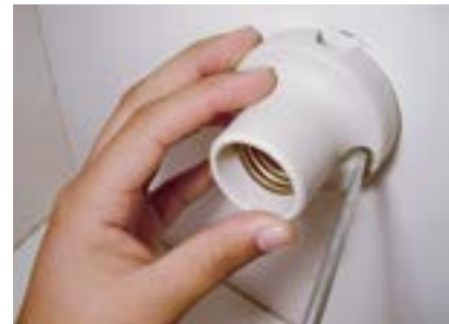
40. Fixar bocal com 2 parafusos e porcas.
