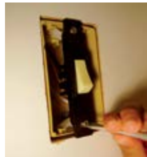
28. Fixar o interruptor na caixa.
