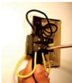
56. Fixar fio amarelo no parafuso de baixo do interruptor.
