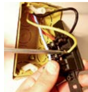
23. Fixar o fio amarelo no parafuso inferior esquerdo do interruptor.
