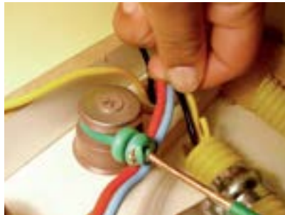
Figura 127 – Instalando duas lâmpadas incandescentes 127V e uma tomada bipolar 127V.
