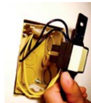
48. Alojjar o interruptor na caixa.
