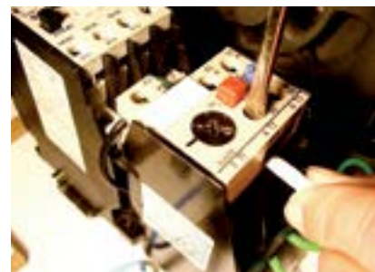
30. Fixar fio azul do interruptor no 96 do relê térmico.
