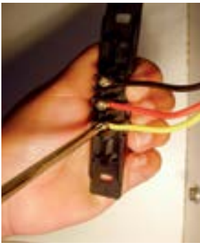
34. Fixar fio amarelo no parafuso de baixo do interruptor.
