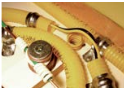
10. Fios nos conduítes.
