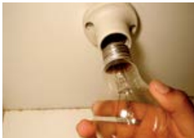
19. Colocar primeira lâmpada 127V no bocal.
