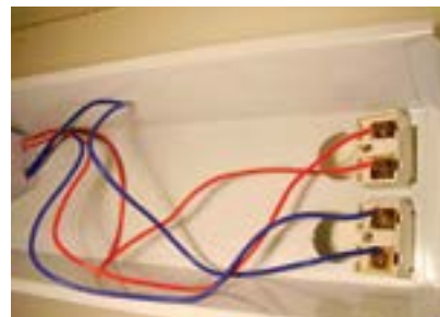
44. Fios do reator instalados.
