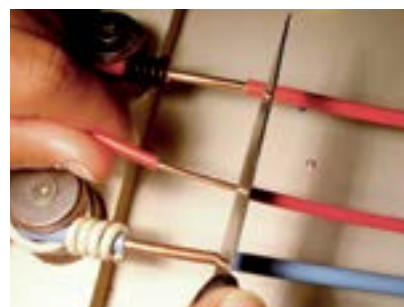
6. Descapar a ponta do fio vermelho (10cm).
