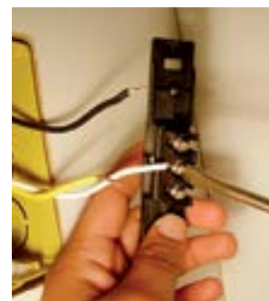
18. Fixar o fio branco no parafuso do meio do interruptor.
