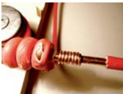
5. Fio vermelho fixado na rede.
