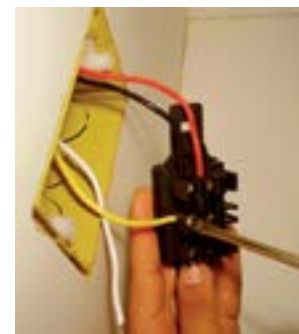
22. Fixar fio amarelo no parafuso do meio do interruptor.
