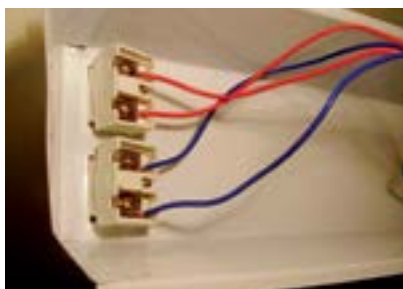
33. Fios do reator instalados.
