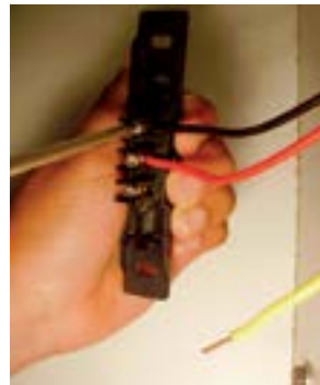
26. Fixar fio preto no parafuso de cima do interruptor.
