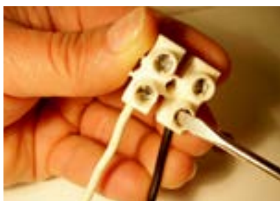
36. Fixar os fios branco e preto do reator no conector.
