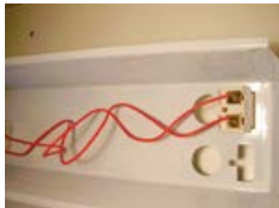
39. Fios vermelhos do reator instalados.
