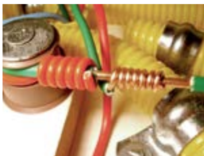
11. Fio verde fixado na rede.
