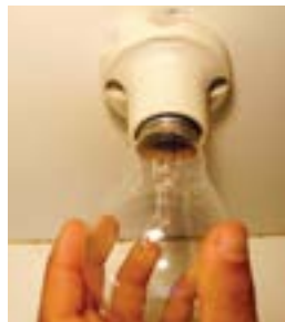
20. Colocar lâmpada 127V no bocal.
