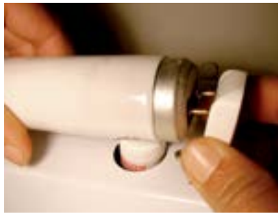
42. Colocar a lâmpada nos soquetes.
