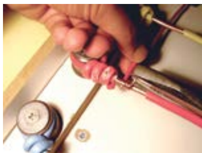
4. Fixar fio vermelho com alicate.
