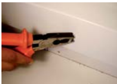
52. Fixar a calha e apertar a porca com alicate.
