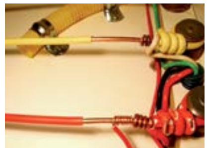
12. Fio vermelho fixado na rede.
