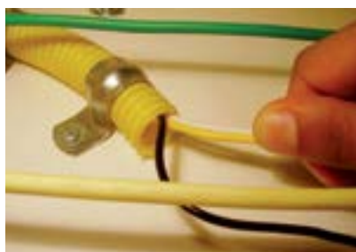
8. Saída dos fios do condute.
