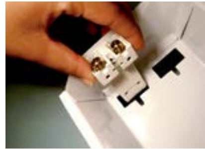
21. Introduzir o primeiro soquete na fenda da calha.
