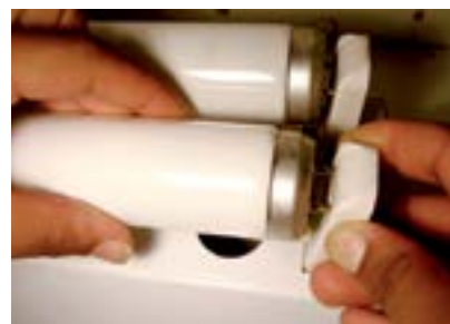
53. Colocar as duas lâmpadas nos soquetes.
