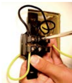
55. Fixar fio preto no parafuso de cima do interruptor.
