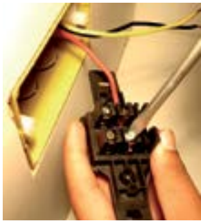
10. Fixar fio vermelho nos dois parafusos do meio.
