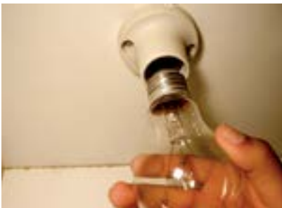
34. Colocar lâmpada 127V no bocal.
