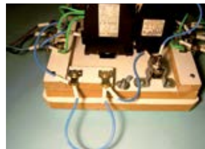
33. Contactor e relê térmico instalado com controle manual por interruptor.
