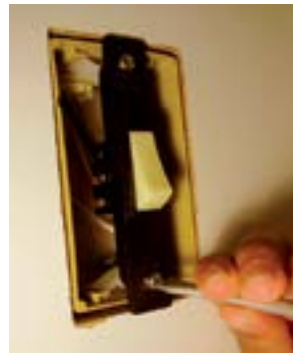
22. Fixar o interruptor na caixa.
