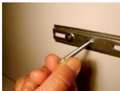
39. Retirar a porca da ponta do parafuso.
