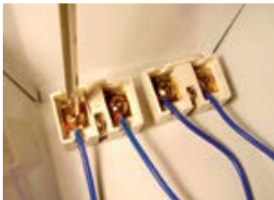
31. Fixar os fios azuis do segundo reator no soquete oposto.
