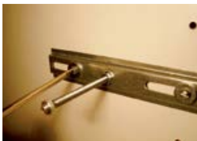
39. Retirar a porca da ponta do parafuso.
