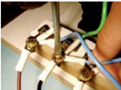
25. Fixar fio azul no terminal de entrada (L2).
