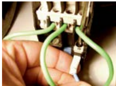
26. Fixar fio azul do L2 no A1 do conector.
