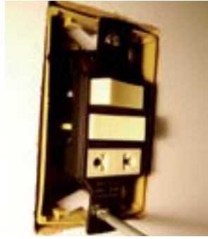
25. Fixar interruptores e a tomada na caixa.
