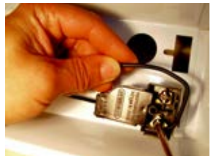
34. Fixar o fio do reator no porta starter.
