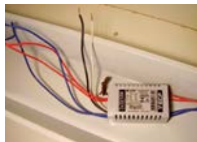
47. Reator eletrônico instalado.
