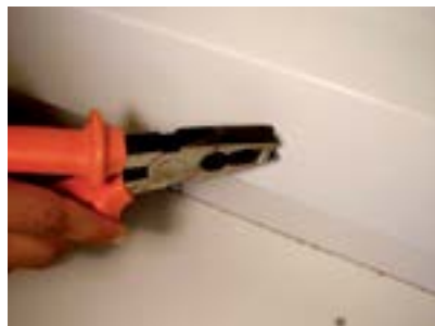
49. Fixar a calha e apertar a porca com alicate.
