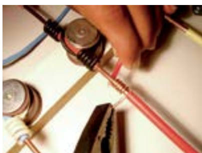
7. Fixar fio vermelho com alicate.
