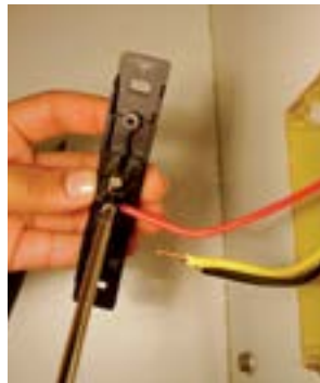
25. Fixar fio vermelho no parafuso do meio do interruptor.
