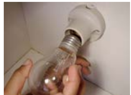
34. Colocar lâmpada 127V no bocal.
