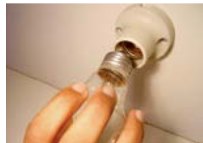
39. Colocar terceira lâmpada 127V no bocal.
