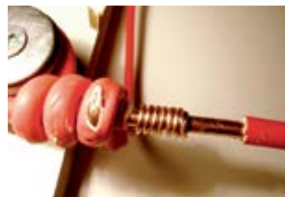
6. Fio vermelho fixado na rede.
