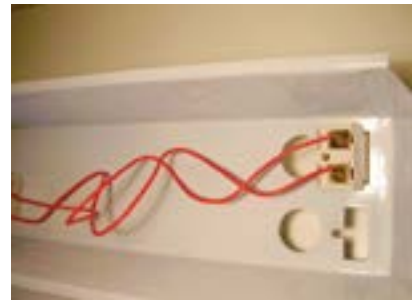
27. Fios vermelhos do reator instalados.
