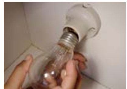
34. Colocar lâmpada 127V no bocal.
