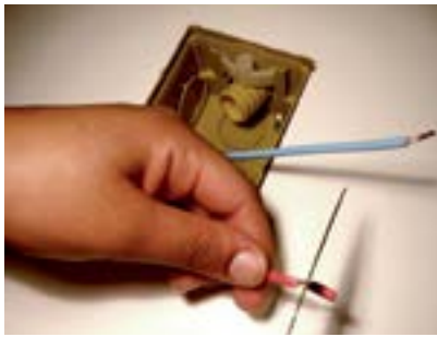
19. Desencapar as pontas dos fios da segunda tomada (1cm).
