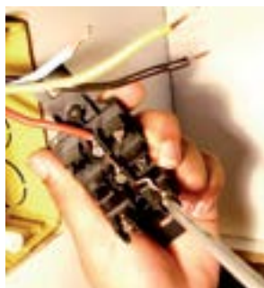
20. Fixar o fio vermelho no parafuso da direita da tomada.
