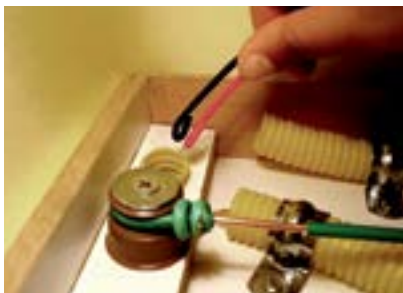
Figura 109 – Instalando campainha “dim dom” com interruptor de uma tecla simples retrátil (pressão).
