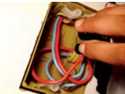
16. Alojamento primeira tomada na caixa.
