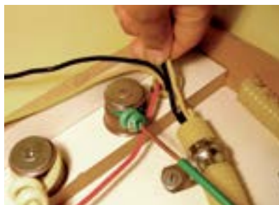
Figura 89 – Instalando duas lâmpadas com interruptor de duas teclas simples.
