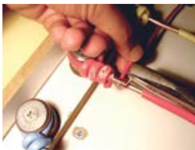
4. Fixar fio vermelho com alicate.
