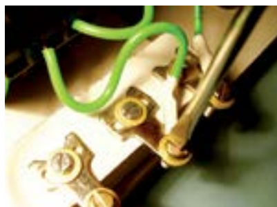
17. Fixar fio do T2 no terminal de saída do meio.
