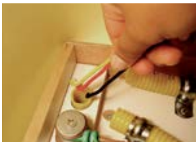
Figura 89 – Instalando duas lâmpadas com interruptor de duas teclas simples.
