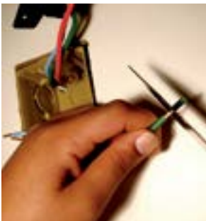
19. Desencapar as pontas dos fios na caixa da primeira tomada (1cm).
