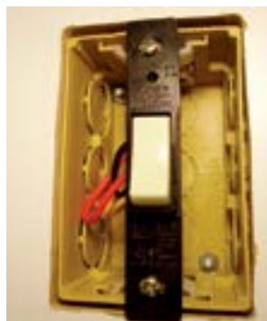
29. Fixar o interruptor na caixa.
