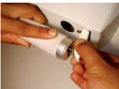
38. Colocar a lâmpada nos soquetes.
