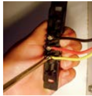
27. Fixar fio amarelo no parafuso de baixo do interruptor.
