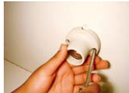
33. Fixar bocal com 2 parafusos e porcas.
