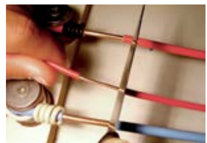
6. Desencapar a ponta do fio vermelho (10cm).
