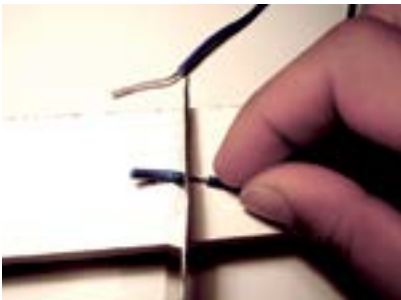
28. Desencapar as pontas dos fios azuis do reator.
