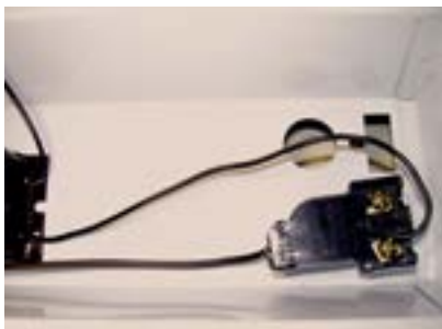
47. Fios instalados no porta-starter.
