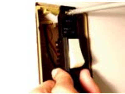
17. Fixar interruptor na caixa.
