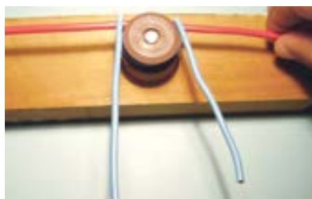
2. Dar uma volta na roldana.
