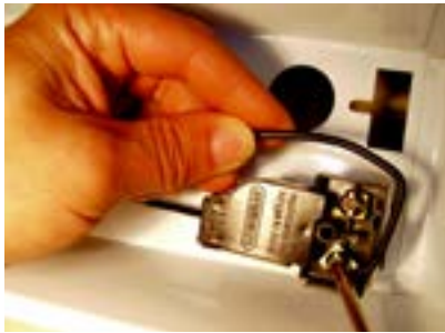
34. Fixar fio do reator no porta starter.
