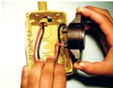
2. Distribuir os fios dentro da caixa.
