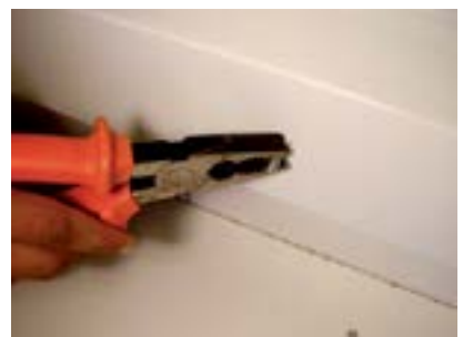
40. Fixar a calha e apertar a porca com alicate.
