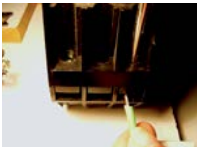
13. Fixar fio no T3 do relê térmico.
