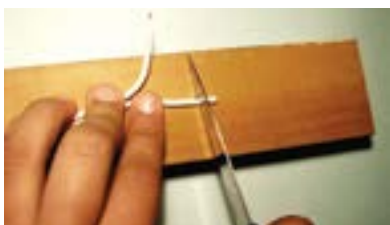
4. Descapar pontas dos cabos.
