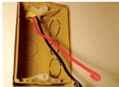
Figura 109 – Instalando campainha “dim dom” com interruptor de uma tecla simples retrátil (pressão).
