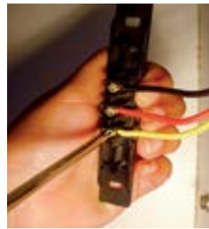
27. Fixar fio amarelo no parafuso de baixo do interruptor.
