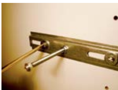
46. Fixar suporte com dois parafusos, arruelas e porcas.
