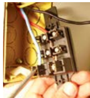
21. Fixar o fio azul no parafuso esquerdo da tomada.
