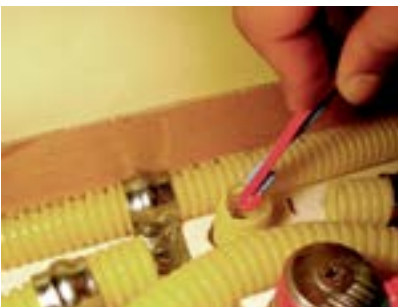
1. Introduzir os fios azul e vermelho no conduíte (2,5mm 2 ).
