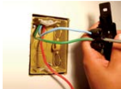
15. Fixar fio verde no parafuso do meio da tomada.
