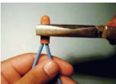
1. Introduzir as pontas dos fios e apertar com alicate.
