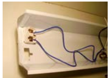
43. Fios azuis do reator instalados.
