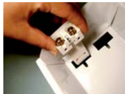
21. Introduzir o primeiro soquete na calha.
