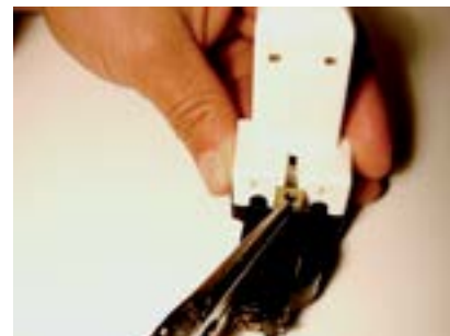
Figura 135 – Instalando a segunda lâmpada (duas lâmpadas fluorescentes 20W com 2 reatores convencionais 220V x 20W).
