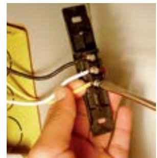
20. Fixar fio amarelo no parafuso de baixo do interruptor.
