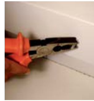
40. Fixar a calha e apertar a porca com alicate.
