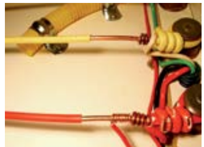
12. Fio vermelho fixado na rede.
