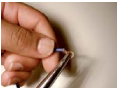
41. Fazer anel (olhal) nas pontas dos fios azuis do reator.
