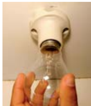
29. Colocar a lâmpada de 127V no bocal.
