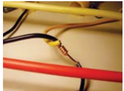
24. Fio amarelo fixado no preto.
