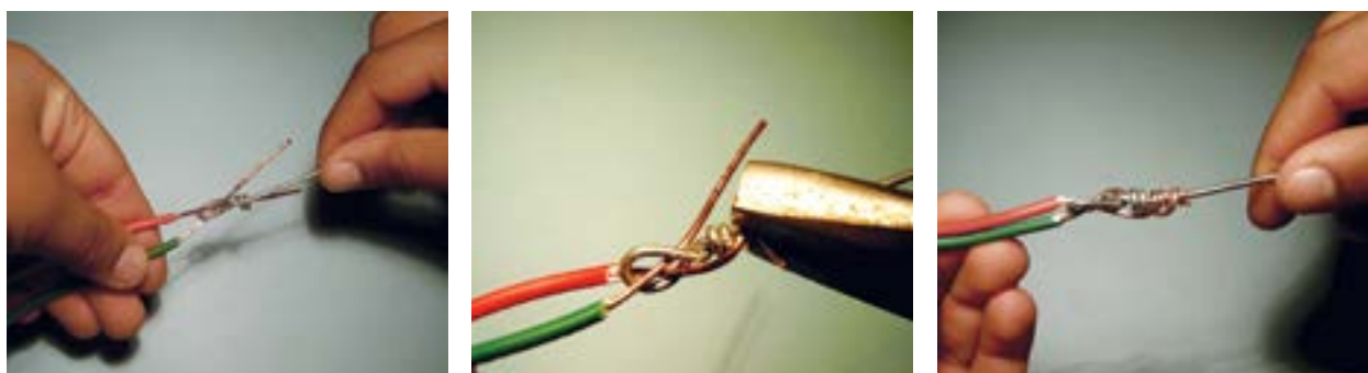
Figura 58 – Amarrando dois conduítes em arame guia para passagem em eletrodutos.
