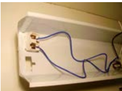
31. Fios azuis do reator instalados.
