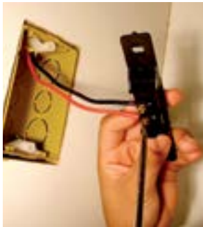
13. Fixar fio vermelho no interruptor.
