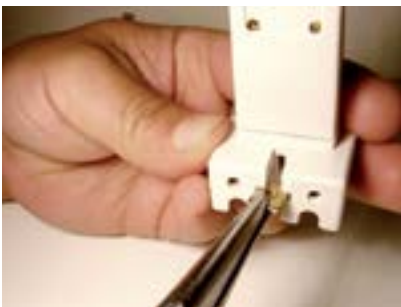
Figura 135 – Instalando a segunda lâmpada (duas lâmpadas fluorescentes 20W com 2 reatores convencionais 220V x 20W).
