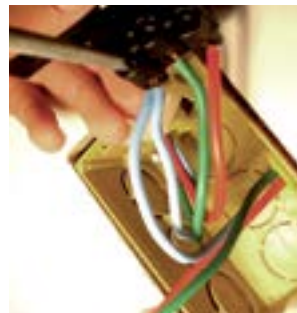
20. Fixar 2 fios azuis no parafuso de cima da primeira tomada.
