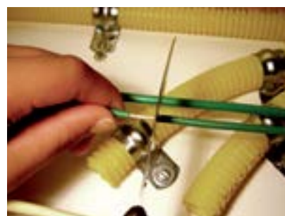
9. Descapar a ponta do fio verde (10cm).
