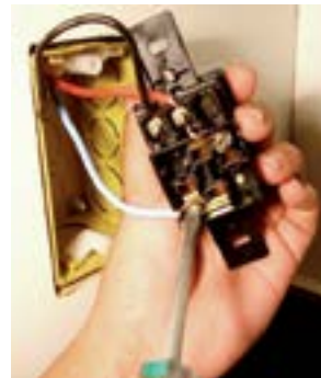
22. Fazer anel e fixar o fio azul no parafuso inferior da tomada.
