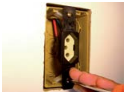
18. Fixar tomada na caixa.
