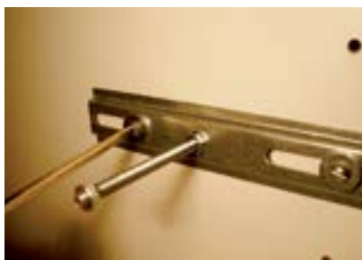
51. Retirar a porca da ponta do parafuso.
