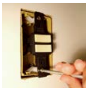
22. Fixar o interruptor na caixa.
