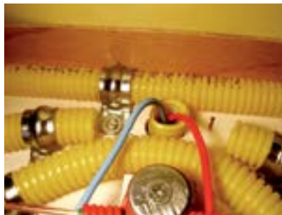
Figura 111 – Instalando uma tomada bipolar 127V.
