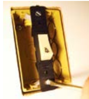
15. Fixar interruptor na caixa.
