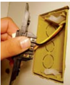
28. Alojjar o interruptor na caixa.
