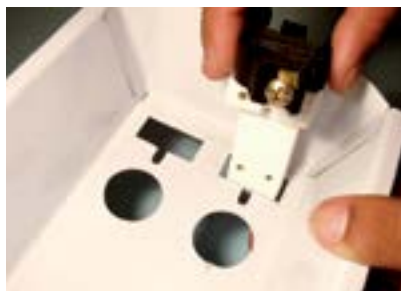
24. Introduzir o segundo soquete (com porta starter) na calha.
