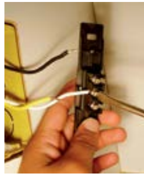
18. Fixar fio branco no parafuso do meio do interruptor.
