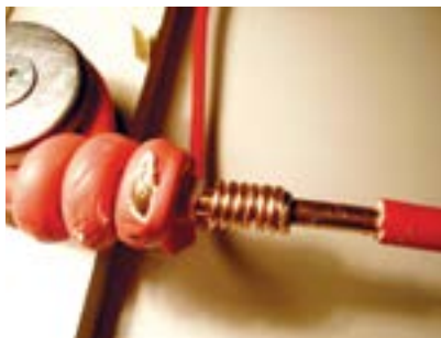
5. Fio vermelho fixado na rede.
