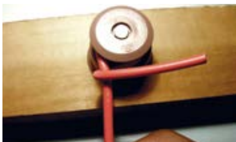
1. Prender a ponta do fio e passar por baixo.
