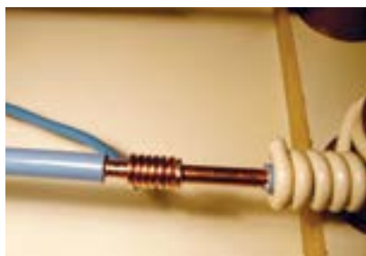
10. Fio fixado na rede.
