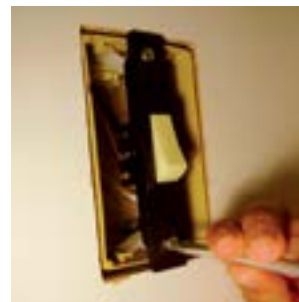
22. Fixar o interruptor na caixa.
