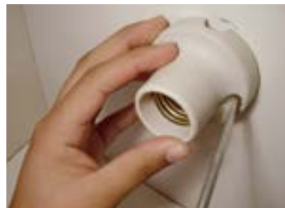
33. Fixar bocal com 2 parafusos e porcas.
