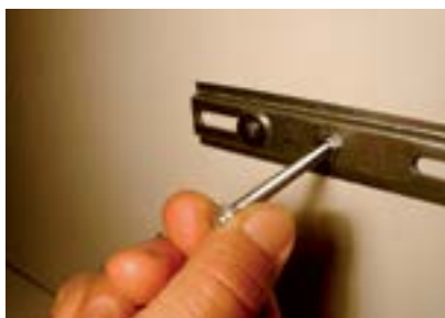
38. Fixar o suporte com dois parafusos, arruelas e porcas.
