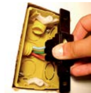
26. Alojara segunda tomada na caixa.
