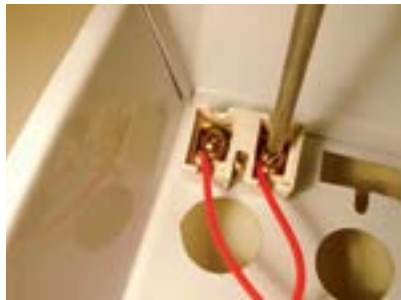
26. Fixar os fios vermelhos do reator no soquete.
