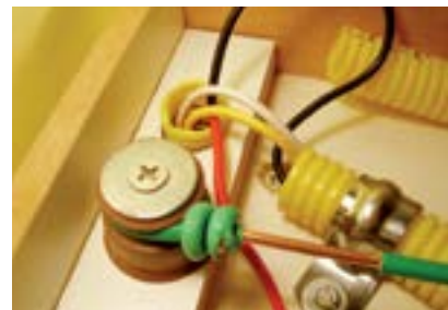
3. Fios nos condutes.
