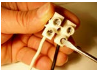
48. Fixar os fios branco e preto do reator no conector.
