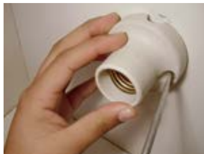
33. Fixar bocal com 2 parafusos e porcas.
