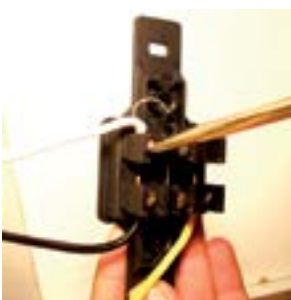
21. Fixar o fio branco juntamente com o diodo no parafuso de cima do interruptor.
