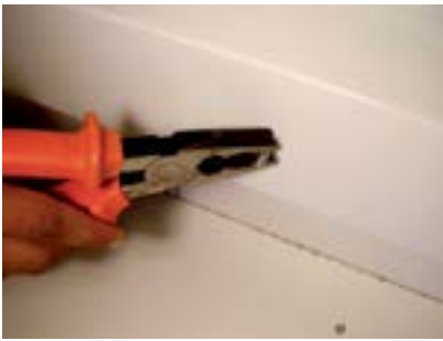
48. Fixar a calha e apertar a porca com alicate.
