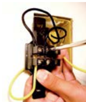
46. Fixar fio preto no parafuso de cima do interruptor.
