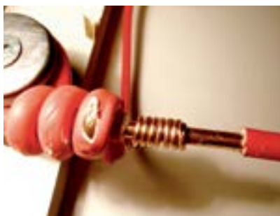
5. Fio vermelho fixado na rede.
