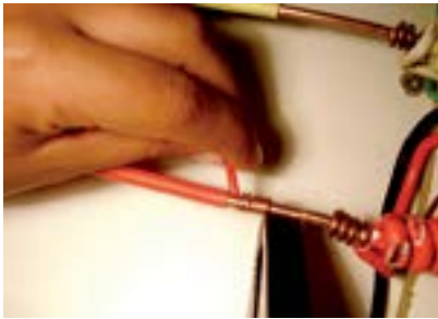
11. Fixar fio vermelho com alicate.
