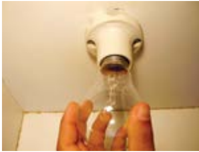
19. Colocar primeira lâmpada 127V no bocal.
