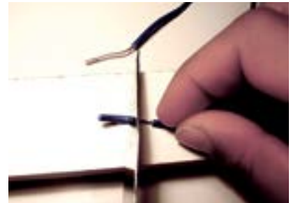
27. Descapar as pontas dos fios azuis do primeiro reator.
