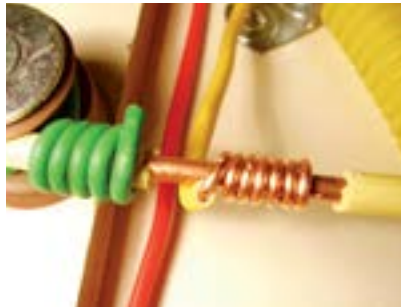
11. Fio amarelo fixado na rede.
