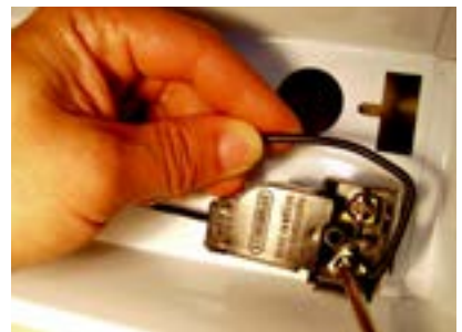
46. Fixar fio do reator no porta-starter.
