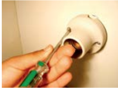
29. Fixar bocal com 2 parafusos e porcas.
