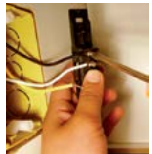
25. Fixar fio preto no parafuso de cima do interruptor.
