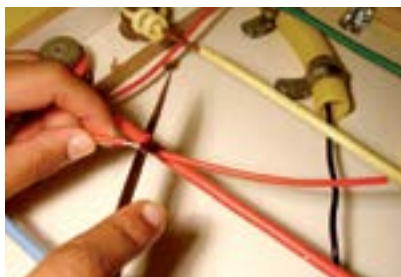
Figura 93 – Instalando em série duas lâmpadas incandescentes 127V na rede de 220V, com interruptor de uma tecla simples.
