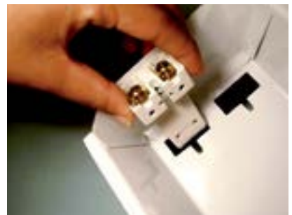
21. Introduzir o primeiro soquete na calha.
