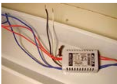
35. Reator eletrônico instalado.
