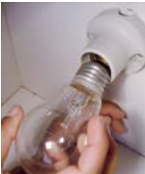
41. Colocar lâmpada 127V.
