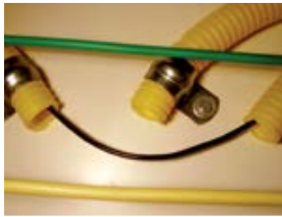
8. Fio preto nos conduítes.
