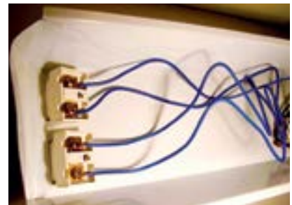
33. Fios azuis dos reatores instalados.
