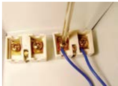
29. Fixar os fios azuis do primeiro reator no soquete.
