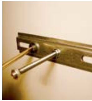
38. Fixar o suporte com dois parafusos, arruelas e porcas.
