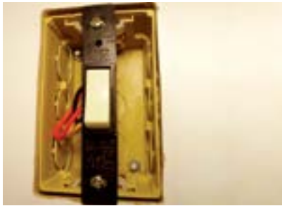
29. Fixar o interruptor na caixa.
