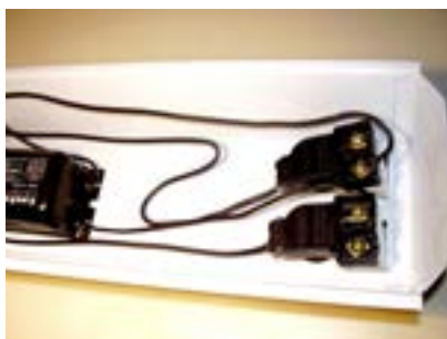
43. Porta starters com fios instalados.
