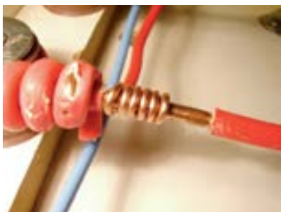
10. Fio vermelho fixado na rede.
