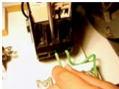
14. Fixar fio no T2 do relê térmico.
