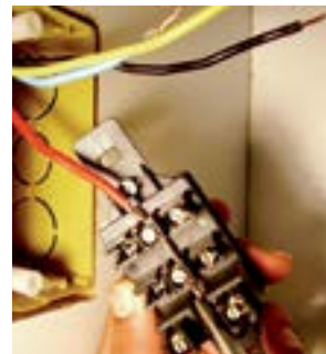
18. Fixar fio vermelho nos parafusos do meio do interruptor.
