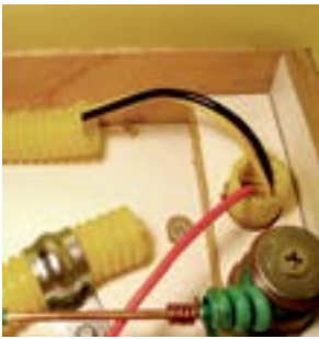
7. Fios introduzidos no conduto.
