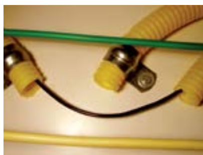
8. Fio preto nos conduítes.
