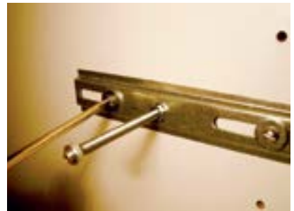
47. Fixar suporte com dois parafusos, arruelas e porcas.
