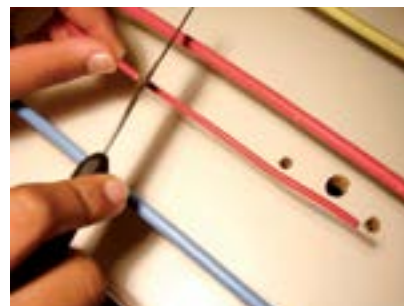
3. Descapar a ponta do fio vermelho (10cm).
