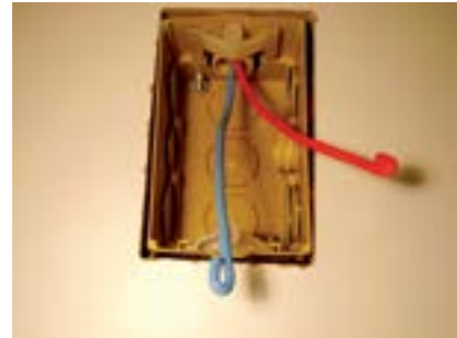
9. Fios na caixa.
