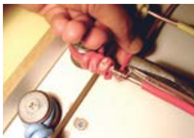
5. Fixar fio vermelho com alicate.
