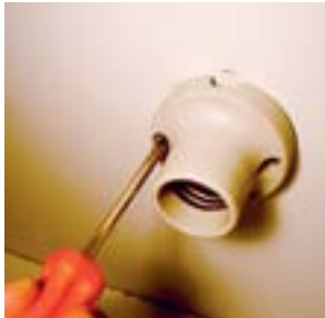
47. Fixar bocal com dois parafusos e porcas.
