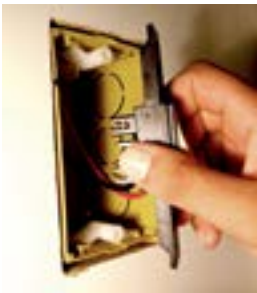
14. Alojjar interruptor na caixa.
