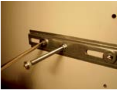
47. Fixar o suporte com dois parafusos, arruelas e porcas.
