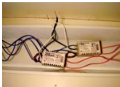
35. Reatores eletrônicos instalados.
