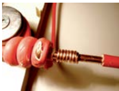
5. Fio vermelho fixado na rede.
