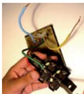
18. Fixar o fio verde nos dois parafusos da direita da tomada.
