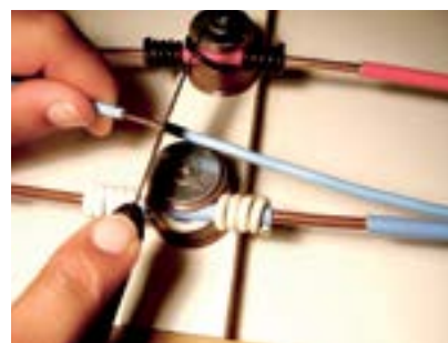
3. Descapar a ponta do fio azul (10cm).
