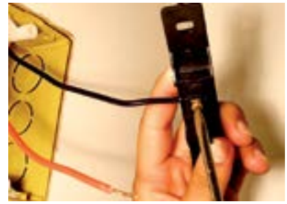
12. Fixar fio preto no parafuso de cima do interruptor.
