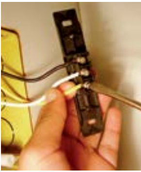
20. Fixar fio amarelo no parafuso de baixo do interruptor.
