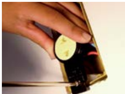
17. Fixar primeira tomada na caixa.
