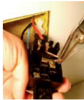
18. Fazer anel (olhal) na ponta do fio vermelho (1º passo).
