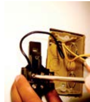
44. Fixar fio preto no parafuso de cima do interruptor.
