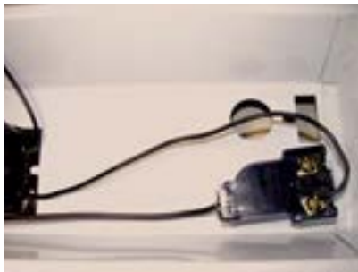
35. Fios instalados no porta starter.
