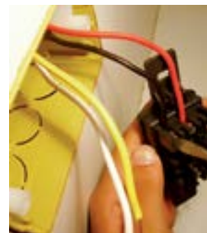
21. Fixar fio preto no primeiro parafuso do interruptor.
