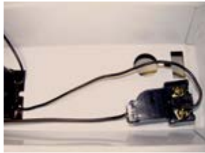
35. Fios instalados no porta starter.
