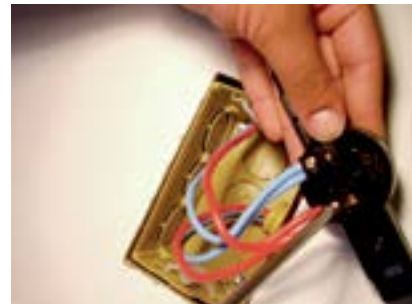
15. Fixar os fios azul e vermelho na primeira tomada juntos.
