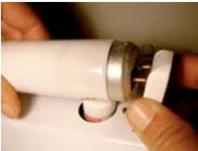
54. Colocar a lâmpada nos soquetes.
