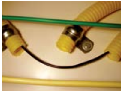
8. Fio preto nos conduítes.
