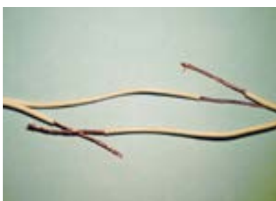
2. Desencapar pontas dos cabos.
