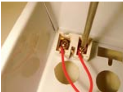
38. Fixar fios vermelhos do reator no soquete.
