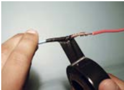
Figura 66 – Fazendo isolamentos com fitas isolantes antichama.
