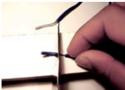
39. Desencapar as pontas dos fios azuis do reator (2,5cm).
