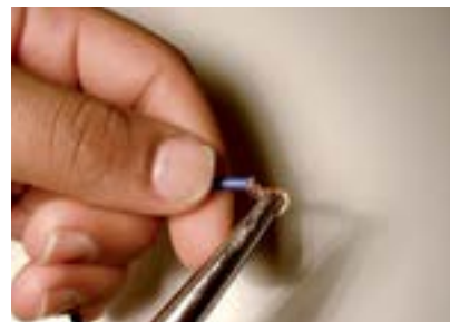
28. Fazer anel (olhal) nas pontas dos fios azuis do reator.
