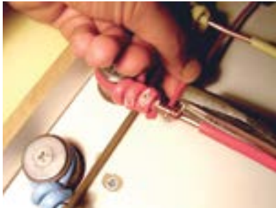
4. Fixar o fio vermelho com alicate.
