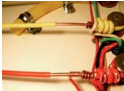
12. Fio vermelho fixado na rede.
