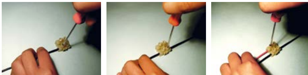
Figura 69 – Fazendo emendas de condutores com conectores do tipo “dado”.
