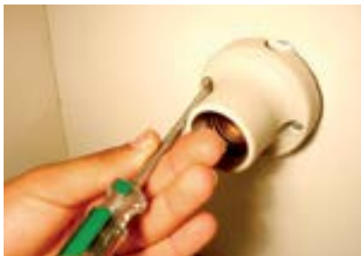
18. Fixar bocal com 2 parafusos e porcas.
