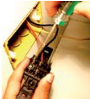
11. Fixar fio preto no parafuso de cima.
