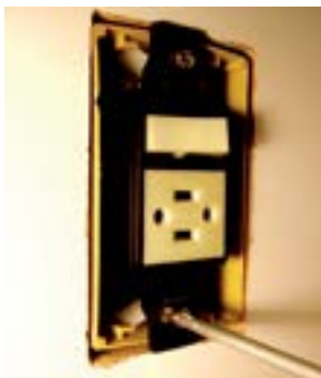
24. Fixar interruptor e tomada na caixa.
