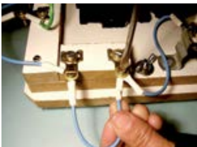
31. Fixar fio azul nos dois terminais laterais.
