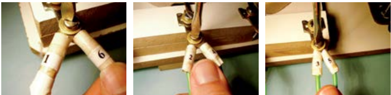
Figura 155 – Instalando um motor elétrico trifásico na rede de 220V (tensão menor ou em triângulo).
