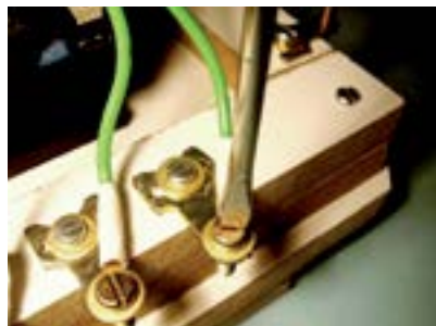
11. Fixar fio L1 do contactor no terminal de entrada direito.
