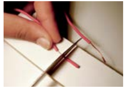
24. Descapar as pontas dos fios vermelhos do primeiro reator.
