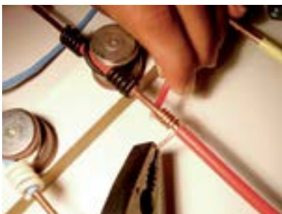
7. Fixar fio vermelho com alicate.
