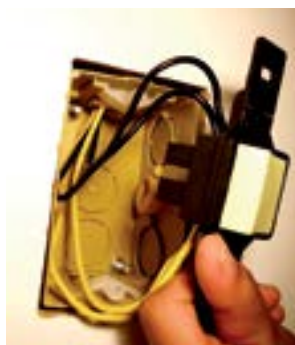
57. Alojamento do interruptor na segunda caixa.
