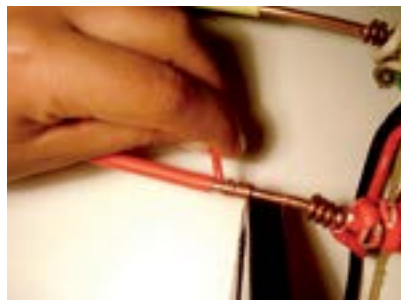
11. Fixar fio vermelho com alicate.
