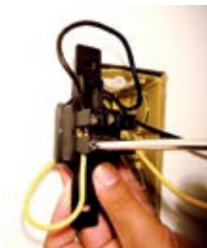
45. Fixar fio amarelo no parafuso de baixo do interruptor.
