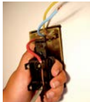
14. Fixar o fio vermelho nos dois parafusos da tomada.
