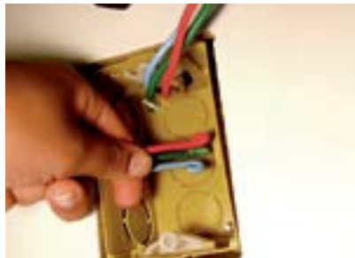
17. Introduzir fios azul, verde e vermelho no condute.
