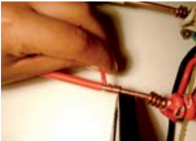
11. Fixar fio vermelho com alicate.
