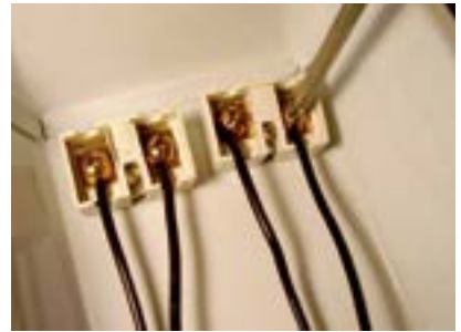
44. Fixar segundo fio do primeiro soquete da segunda lâmpada.
