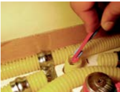
Figura 111 – Instalando uma tomada bipolar 127V.
