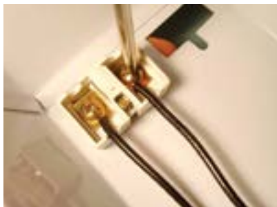
45. Fixar o segundo fio no primeiro soquete.
