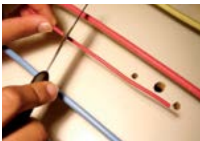
4. Desencapar a ponta do fio vermelho (10cm).
