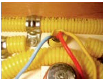
2. Fios no condute.
