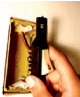
14. Alojjar o interruptor na caixa.
