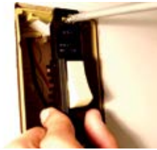
17. Fixar interruptor na caixa.
