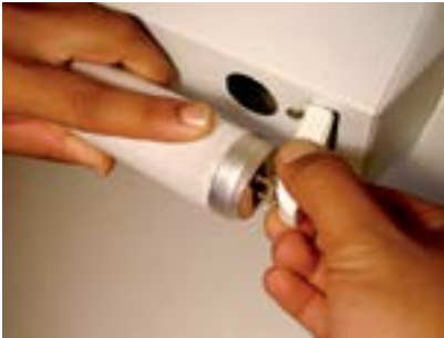
50. Colocar a lâmpada nos soquetes.
