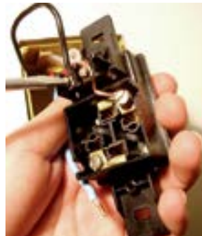
21. Fixar fio preto no parafuso superior esquerdo do interruptor.
