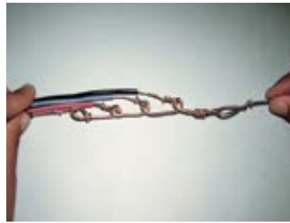
5. Conjunto de 4 fios presos no arame guia.
