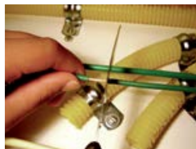
9. Desencapar a ponta do fio verde (10cm).
