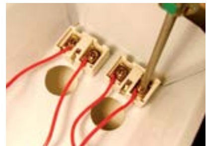
30. Fixar os fios vermelhos do segundo reator no soquete oposto.
