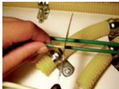
9. Desencapar a ponta do fio verde (10cm).
