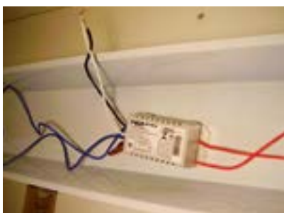
44. Reator eletrônico instalado.
