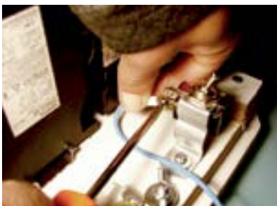
28. Fixar fio azul do terminal lateral no interruptor.
