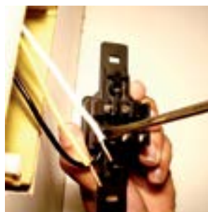
18. Fixar fio preto no parafuso inferior esquerdo do interruptor.
