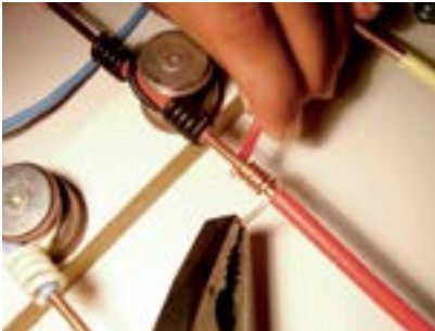
7. Fixar o fio vermelho com alicate.
