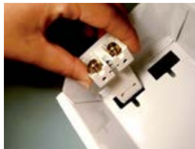
33. Introduzir o primeiro soquete na calha.
