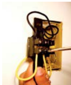
47. Fixar fio amarelo no parafuso de baixo do interruptor.
