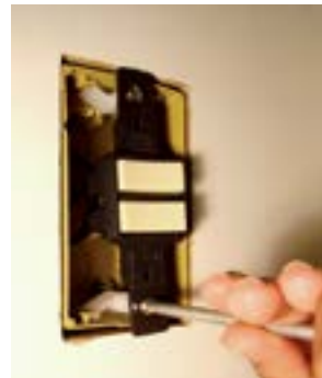
15. Fixar o interruptor na caixa.
