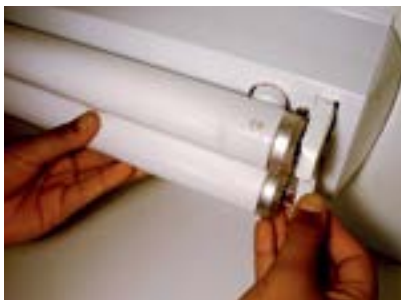
51. Colocar as duas lâmpadas nos soquetes.
