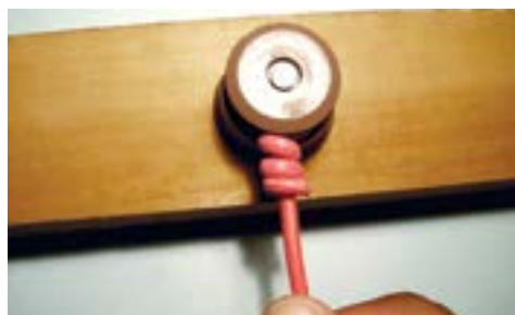
2. Enrolar a ponta do fio com alicate.
