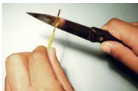
Figura 70 – Limpando superfície do condutor.
