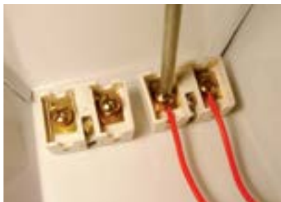
42. Fixar os fios vermelhos do reator no soquete oposto.
