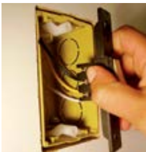
21. Alojjar o interruptor na caixa.
