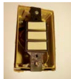
26. Interruptor fixado na caixa.
