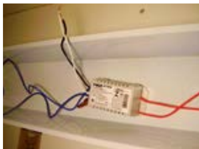
32. Reator eletrônico instalado.
