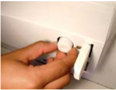
41. Colocar starter no porta starter e girar para a direita.
