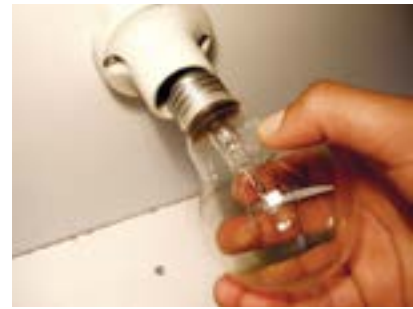
33. Colocar segunda lâmpada.
