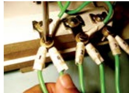
21. Fixar os terminais 1 e 6 do motor no terminal de saída esquerdo.
