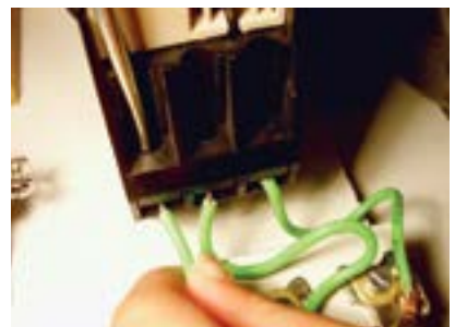
15. Fixar fio no T1 do relê térmico.
