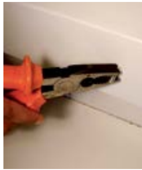
52. Fixar a calha e apertar a porca com alicate.
