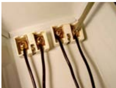
40. Fixar fio preto no segundo soquete da segunda lâmpada.
