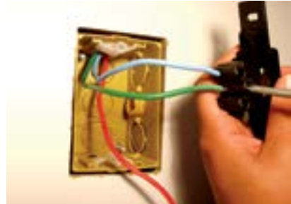
15. Fixar o fio verde no parafuso do meio da primeira tomada.
