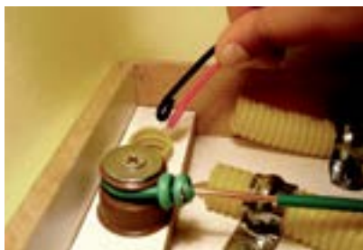
Figura 93 – Instalando em série duas lâmpadas incandescentes 127V na rede de 220V, com interruptor de uma tecla simples.
