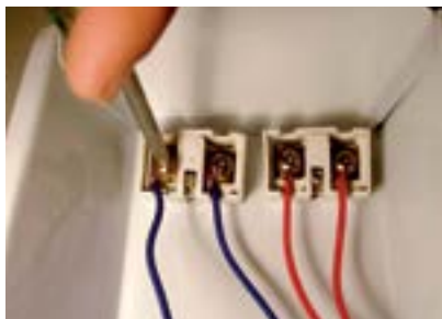
43. Fixar os fios azuis do reator no soquete oposto.
