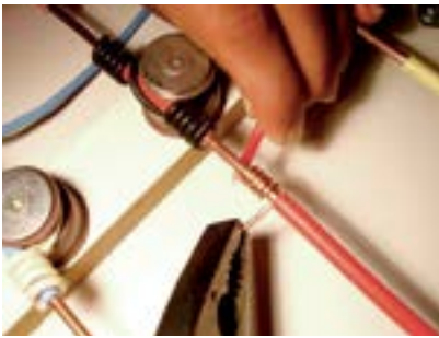
7. Fixar fio vermelho com alicate.
