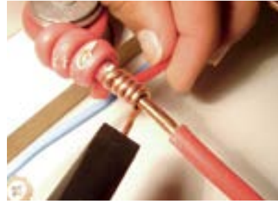
11. Fio vermelho fixado na rede.
