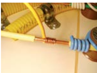
13. Fio amarelo fixado na rede.
