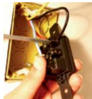
22. Fixar o fio preto no parafuso superior direito do interruptor.
