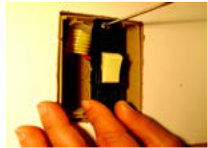
15. Fixar interruptor na caixa.
