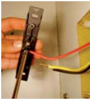
25. Fixar fio vermelho no parafuso do meio do interruptor.
