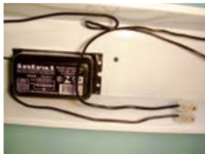
38. Fios instalados no conector.
