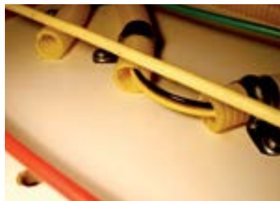
12. Fios nos conduítes.
