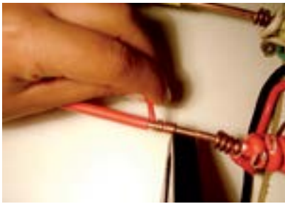
16. Fixar fio vermelho com alicate.
