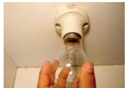
20. Colocar primeira lâmpada 127V x 40W.
