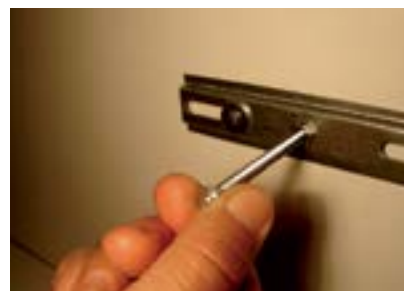
50. Fixar o suporte com dois parafusos, arruelas e porcas.
