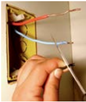
16. Desencapar a ponta dos fios vermelho (5cm), preto e azul (1cm).
