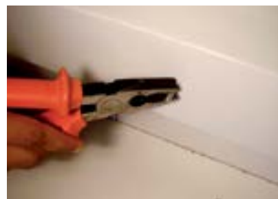
40. Fixar a calha e apertar a porca com alicate.
