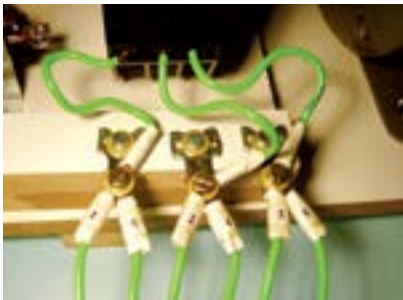
22. Terminais do motor instalados na saída do relê térmico.
