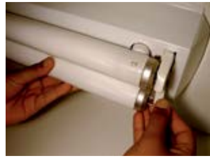
50. Colocar as lâmpadas nos soquetes.
