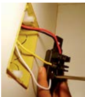
23. Fixar fio branco no parafuso de baixo do interruptor.
