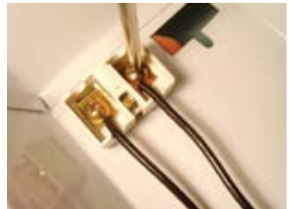
33. Fixar segundo fio no primeiro soquete.
