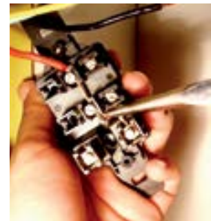
19. Puxar o fio com alicate de bico até o parafuso da tomada.
