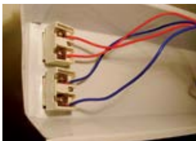
45. Fios do reator instalados.
