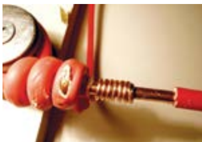
5. Fio fixado na rede.
