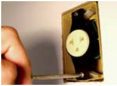
16. Fixar tomada na caixa.
