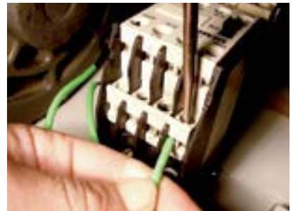
6. Fixar fio no L1 do contactor.
