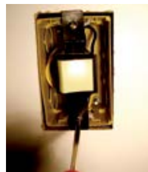
58. Fixar interruptor na segunda caixa.
