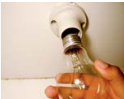
20. Colocar lâmpada 127V no bocal.
