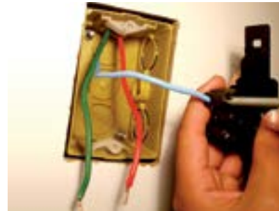
14. Fixar fio azul no parafuso de cima da tomada.
