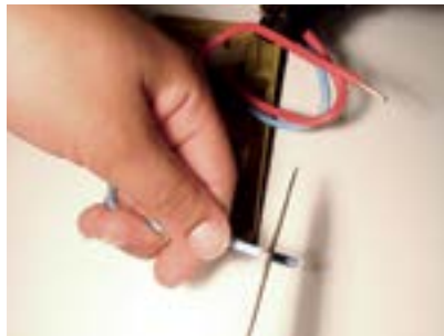
14. Desencapar as pontas dos fios da primeira tomada (1cm).
