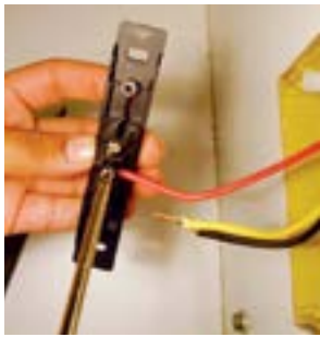
25. Fixar fio vermelho no parafuso do meio do interruptor.
