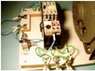
34. Relê térmico instalado (saída).
