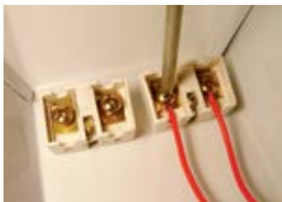
30. Fixar os fios vermelhos do reator no soquete oposto.
