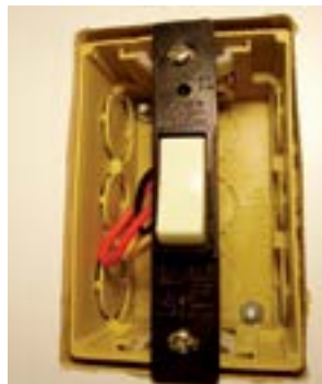
29. Fixar o interruptor na caixa.
