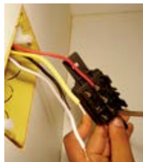
20. Fixar fio vermelho nos 3 parafusos do interruptor.
