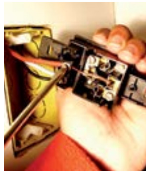
17. Fixar fio vermelho no parafuso superior direito do interruptor.
