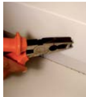
42. Fixar a calha e apertar a porca com alicate.
