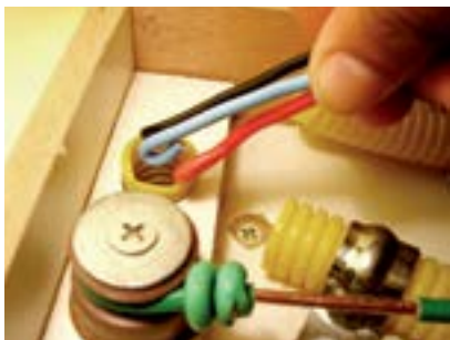
1. Introduzir os fios azul, vermelho (2,5mm 2 ) e preto (1,5mm 2 ) no conduíte.
