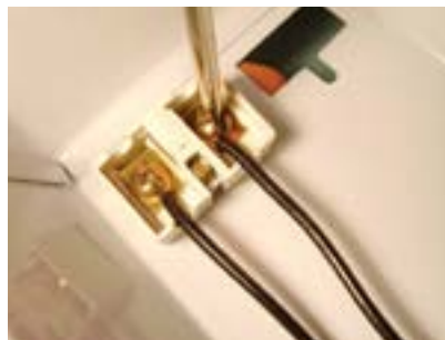
33. Fixar o segundo fio no primeiro soquete.
