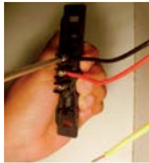
26. Fixar fio preto no parafuso de cima do interruptor.
