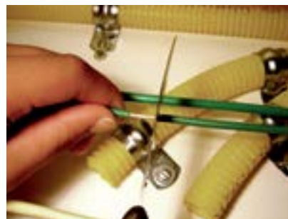
9. Descapar a ponta do fio verde (10cm).
