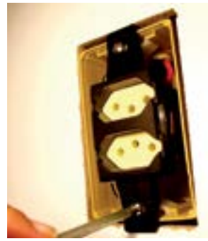
22. Fixar tomada na caixa.
