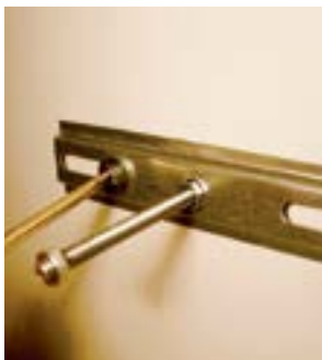
40. Fixar suporte com dois parafusos, arruelas e porcas.
