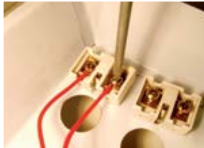
26. Fixar os fios vermelhos do primeiro reator do soquete.
