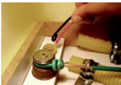
Figura 137 – Instalando uma lâmpada fluorescente 20W com reator eletrônico partida rápida 127V x 20W.
