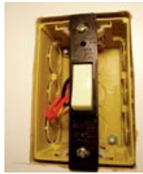
36. Fixar interruptor na caixa.
