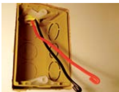
2. Fios na caixa.
