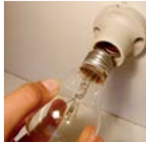
48. Colocar a segunda lâmpada 127V no local.
