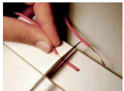
24. Desencapar as pontas dos fios vermelhos do reator (2,5cm).
