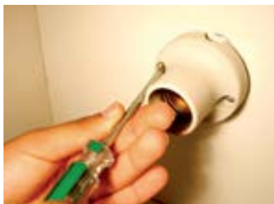
19. Fixar primeiro bocal com 2 parafusos e porcas.
