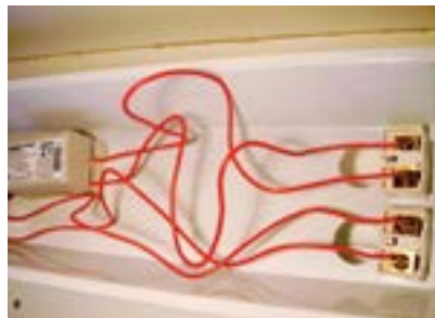
32. Fios vermelhos dos reatores instalados.
