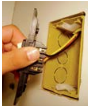
35. Alojjar o interruptor na caixa.
