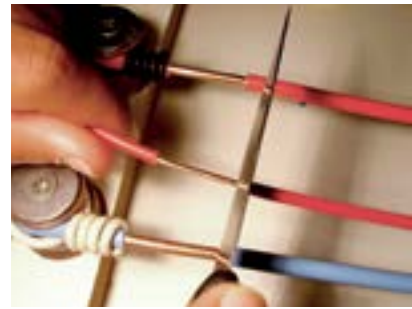
6. Desencapar a ponta do fio vermelho (10cm).
