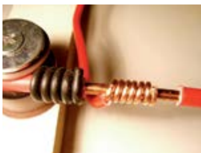
8. Fio vermelho fixado na rede.
