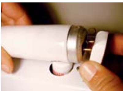
44. Colocar a lâmpada nos soquetes.
