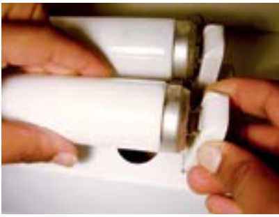
41. Colocar as duas lâmpadas nos soquetes.
