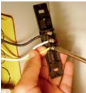
26. Fixar o fio amarelo no parafuso de baixo do interruptor.
