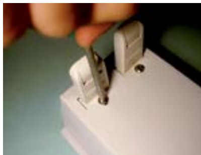
Figura 135 – Instalando a segunda lâmpada (duas lâmpadas fluorescentes 20W com 2 reatores convencionais 220V x 20W).
