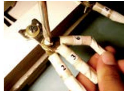
Figura 152 – Instalando um motor elétrico monofásico na rede de 220V (tensão maior ou em série).
