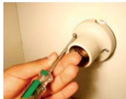
19. Fixar bocal com 2 parafusos e porcas.
