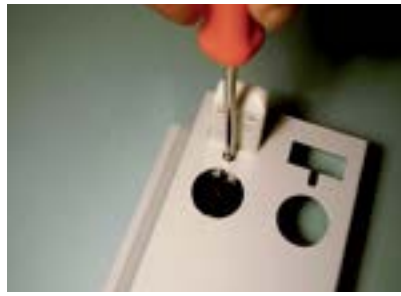
23. Fixar o segundo soquete na calha com parafuso.
