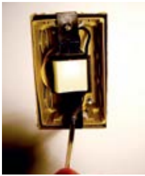
49. Fixar o interruptor na caixa.
