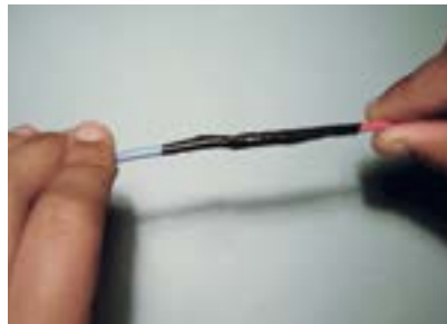
Figura 66 – Fazendo isolamentos com fitas isolantes antichama.
