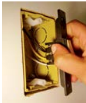
21. Alojjar o interruptor na caixa.
