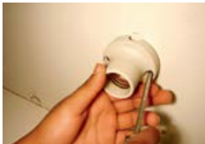
22. Fixar bocal com 2 parafusos e porcas.
