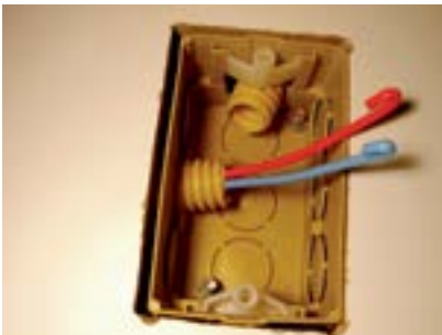
13. Fios na caixa.
