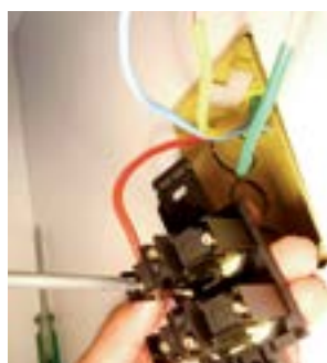
17. Fixar o fio vermelho nos dois parafusos da esquerda da tomada.
