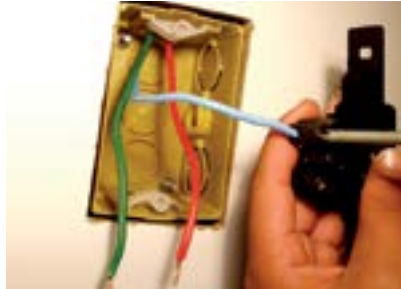
14. Fixar o fio azul no parafuso de cima da primeira tomada.
