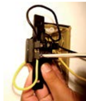
54. Fixar fio amarelo no parafuso de baixo do interruptor.
