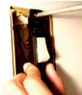
17. Fixar interruptor na caixa.
