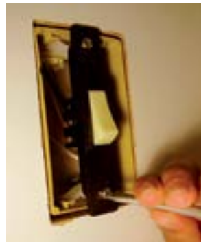
22. Fixar o interruptor na caixa.
