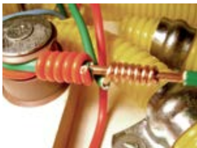
11. Fio verde fixado na rede.
