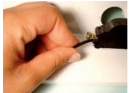
40. Colocar o anel do fio com com parafuso no porta-starter.
