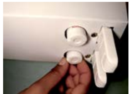
50. Colocar os starters nos portas starters e girar para a direita.
