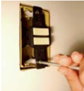
14. Fixar interruptor na caixa.
