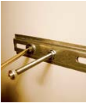
50. Fixar o suporte com dois parafusos, arruelas e porcas.
