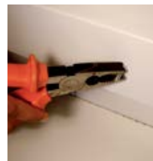
37. Fixar a calha e apertar a porca com alicate.
