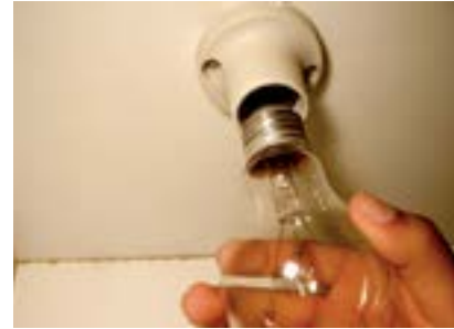
30. Colocar lâmpada 127V no bocal.
