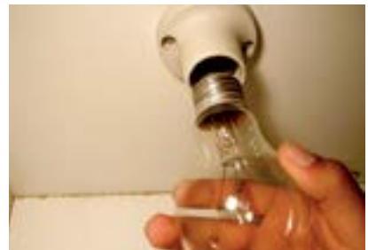
23. Colocar segunda lâmpada 127V no bocal.
