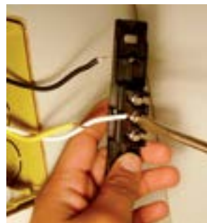
24. Fixar fio branco no parafuso do meio do interruptor.
