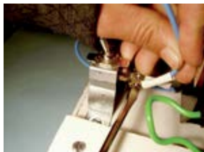
29. Fixar fio azul no outro terminal do interruptor.
