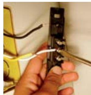
18. Fixar fio branco no parafuso do meio do interruptor.
