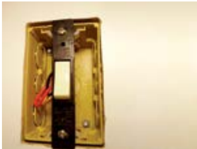
29. Fixar o interruptor na caixa.
