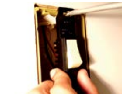
17. Fixar interruptor na caixa.
