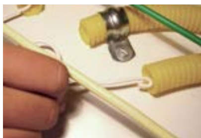
35. Introduzir fio branco no condutite.
