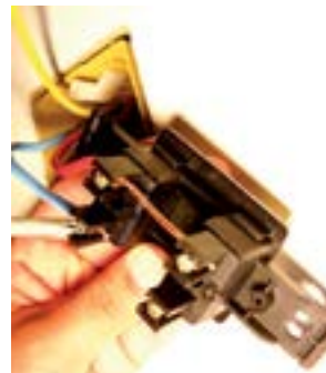
15. Fixar o fio azul no parafuso de cima.
