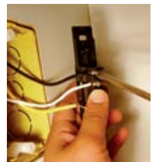
19. Fixar o fio preto no parafuso de cima do interruptor.
