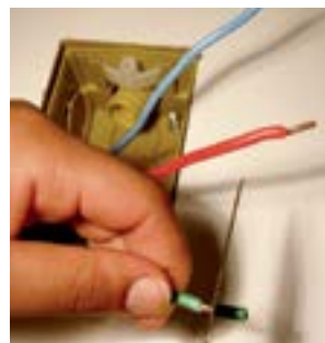
24. Desencapar as pontas dos fios da segunda tomada.
