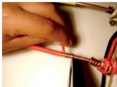
11. Fixar fio vermelho com alicate.
