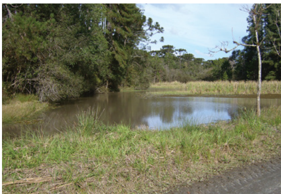
Figura 32 – Construção de açudes.
