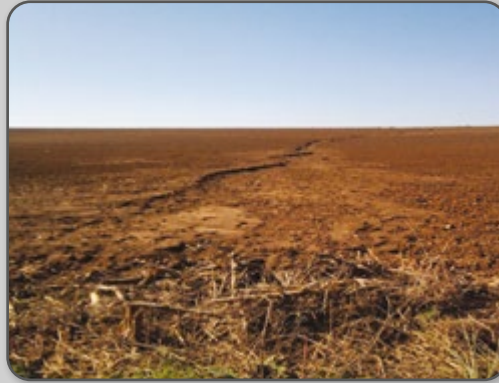
Figura 63 – Erosão mostrando camada compactada.
