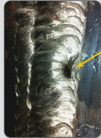
Figura 15 – Deposição insuficiente durante a soldagem (defeito).
