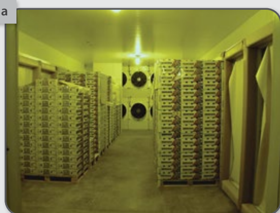
Figura 41 – Retirada do calor de campo com ar forçado (a) e câmara fria comercial, com único produto hortícola (b).
