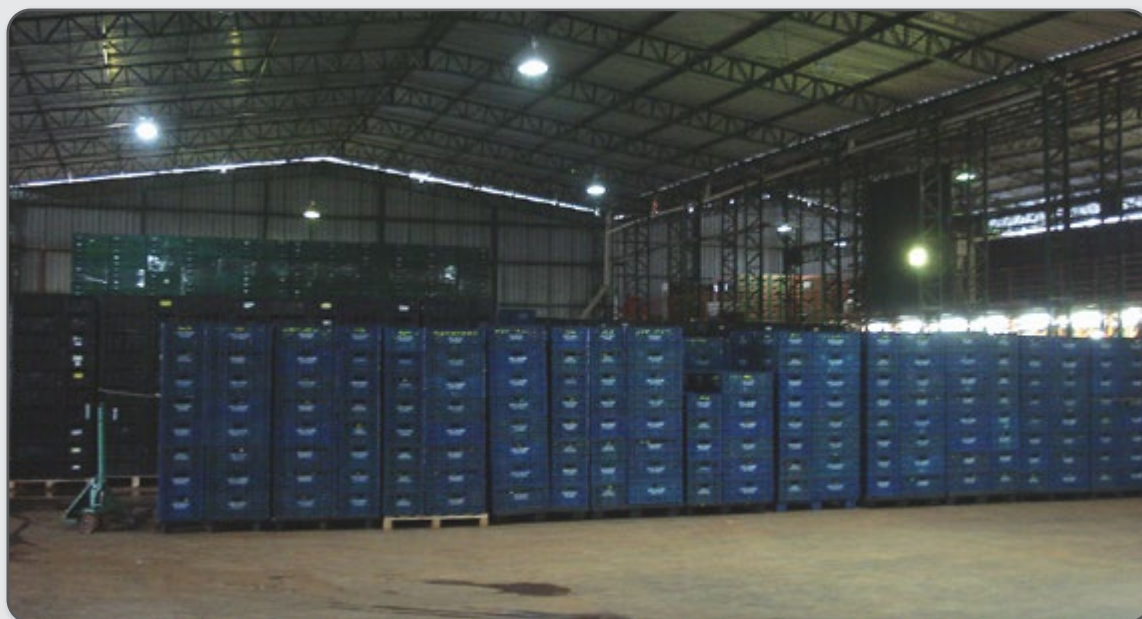
Figura 19 – Área de recebimento de tomates, na planta de beneficiamento estática.
