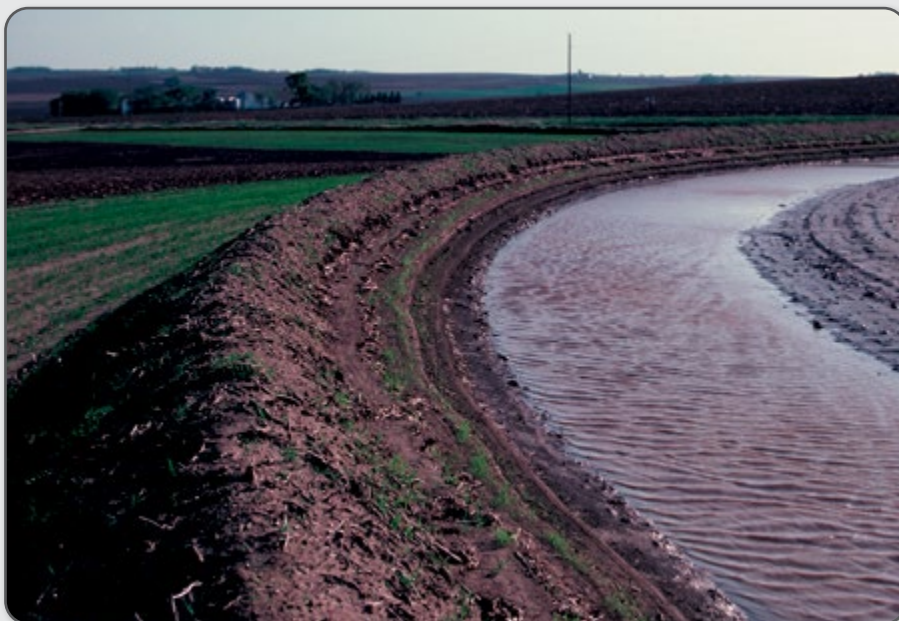
Figura 63 – Vista parcial da água da enxurrada retida em um terraço.
