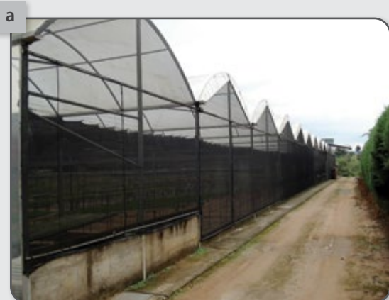
Figura 2 – Tipos de estufas agrícolas. Vista externa e interna de estufa tipo arco (A e B); vista externa e interna de estufa tipo capela (C e D); vista externa e interna de túnel alto (E e F).
