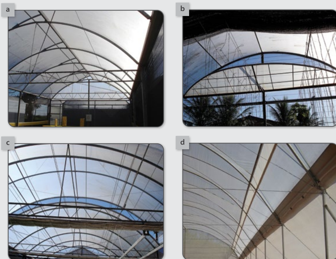
Figura 4 – Diferentes tipos de aberturas para remoção do ar quente do interior das estufas.
