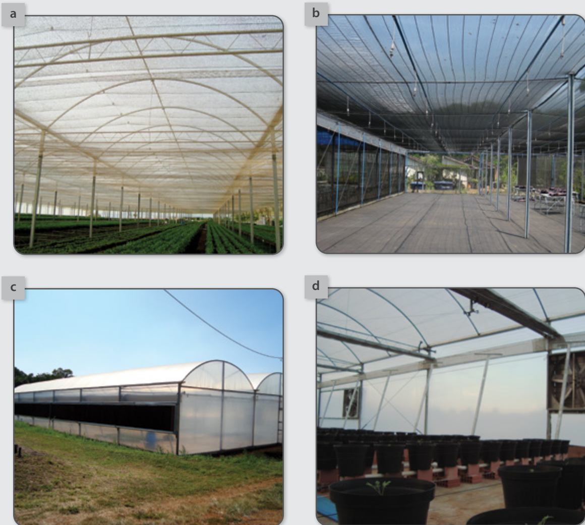
Figura 5 – Estufa com tela termo refletora (A); telado com nebulizadores (B); estufa equipada com sistema de resfriamento tipo Pad & Fan (C e D).
