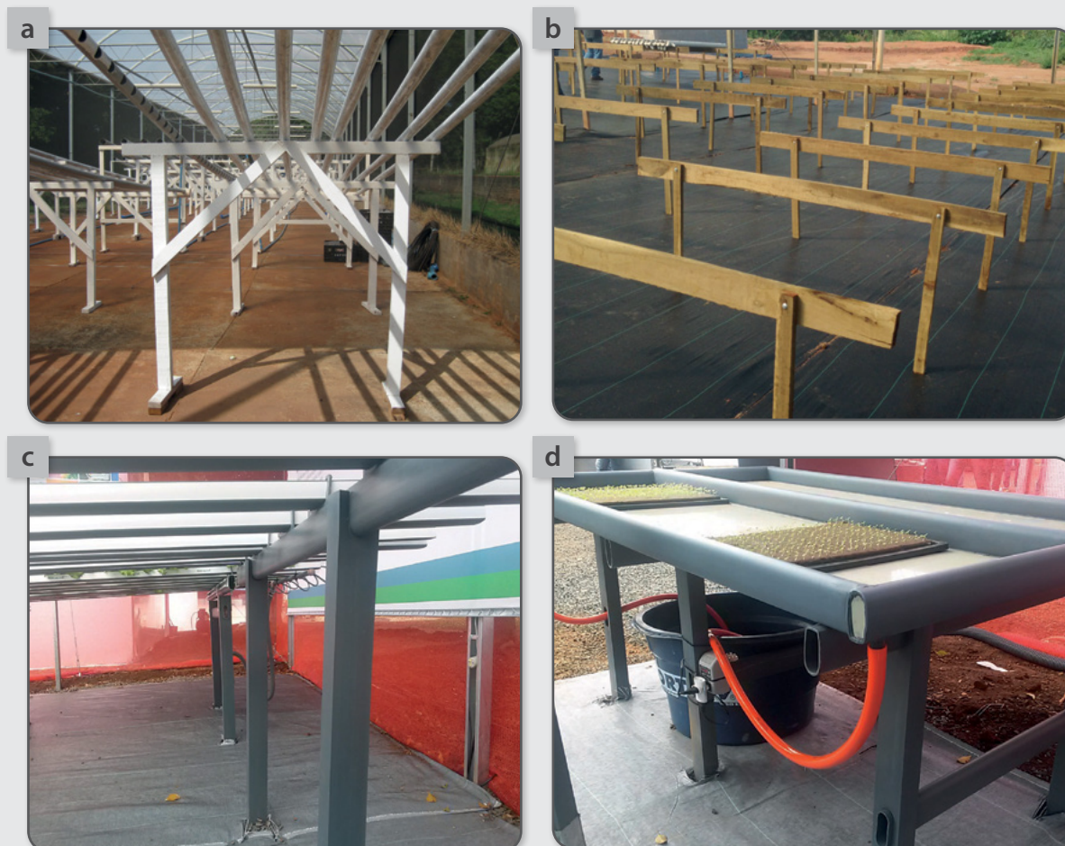
Figura 6 – Estruturas para suporte dos canais de cultivo. Suportes feitos de madeira (a) e (b) e de plástico (c) e (d).
