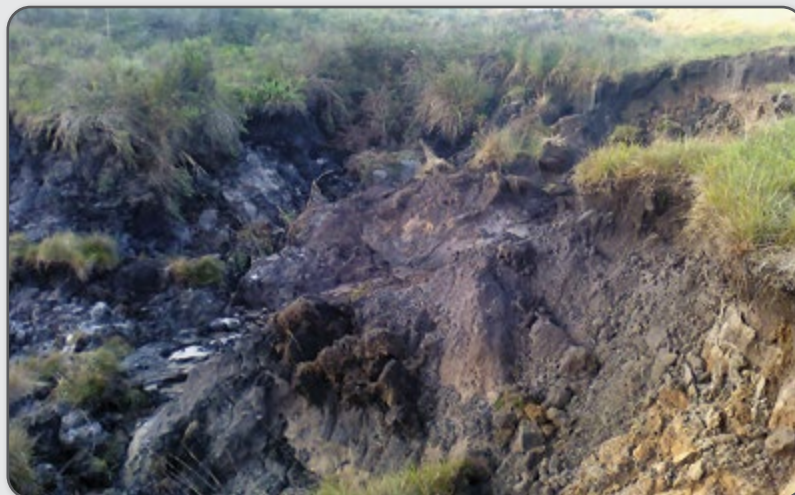
Figura 53 – Voçoroca ativa em uma área de pastagem no município de Palmeira, Paraná.
