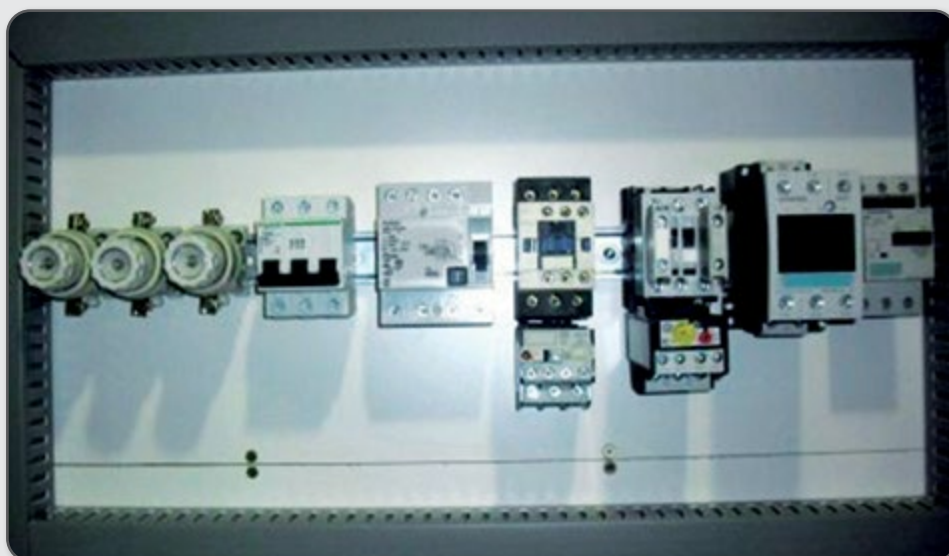
Figura 102 – Dispositivos do circuito principal (carga).
