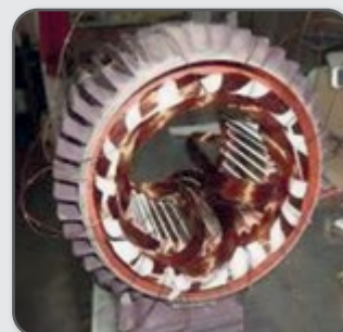
f) Colocação bobinas no motor trifásico.
