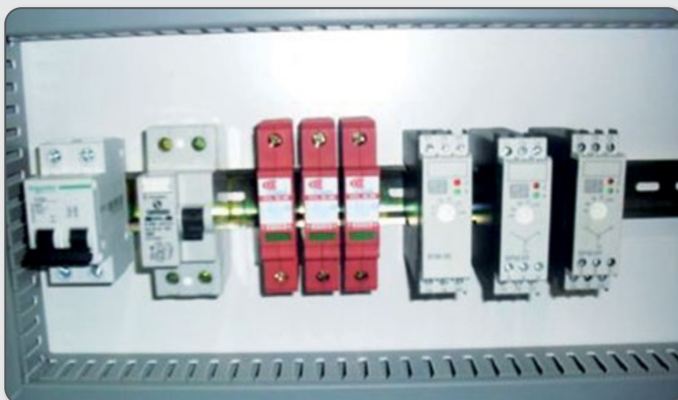
Figura 103 – Dispositivos do circuito de controle.
