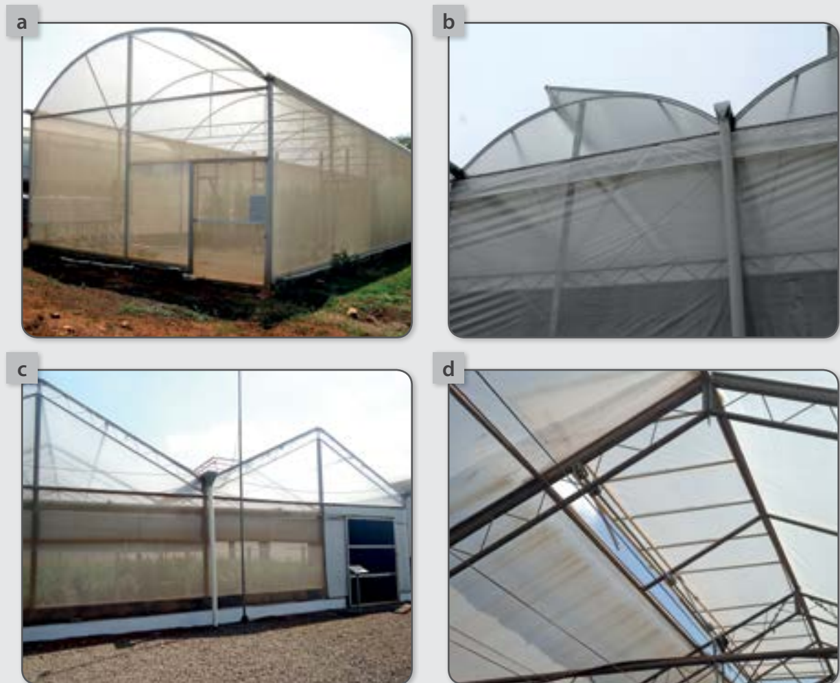
Figura 3 – Modelos de estufas agrícolas mais comumente utilizados no Brasil para cultivo de minitomates: (A) teto em arco; (B) teto em arco com janela zenital (lanternim); (C) tipo capela; (E) abertura de teto em estufa tipo capela.
