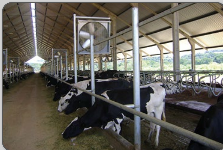
Figura 38 – Ventilação nos cochos, com aspersão.
