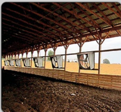
Figura 52 – Ventilação artificial em sistema Compost Barn .
