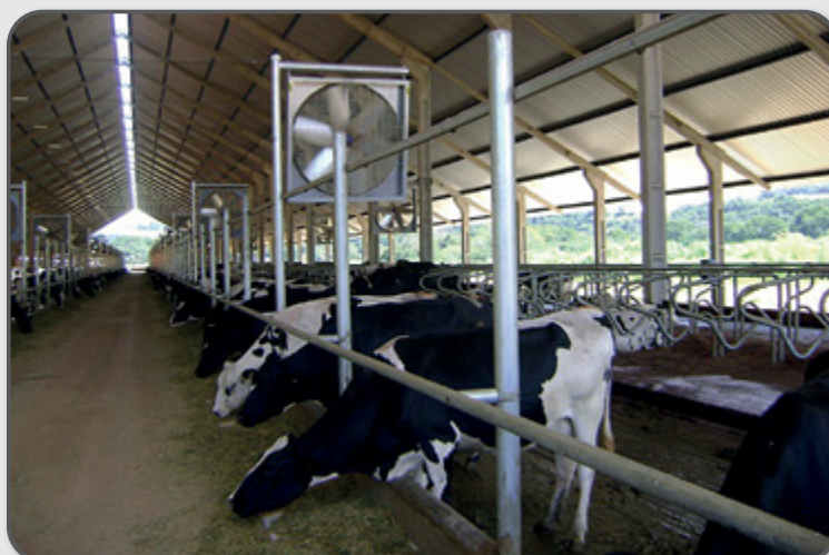
Figura 38 – Ventilação nos cochos, com aspersão.
