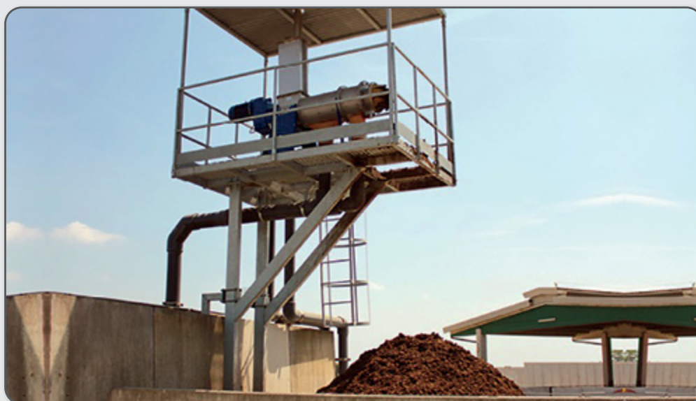
Figura 62 – Detalhes do funcionamento de prensas de roscas separadoras.
