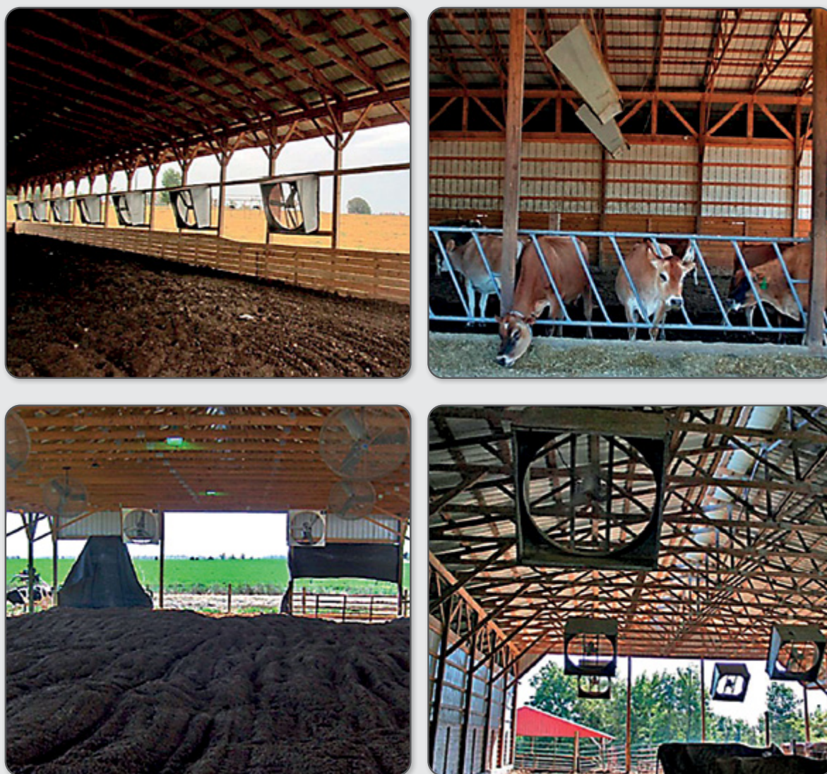
Figura 52 – Ventilação artificial em sistema Compost Barn .
