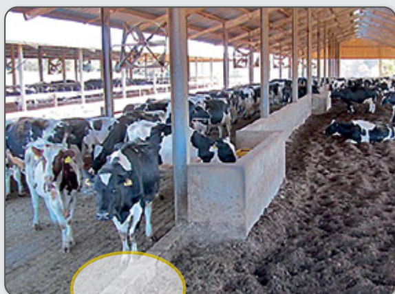
Figura 49 – Vista de um galpão de Compost Barn .
