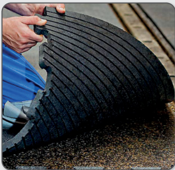
Figura 39 – Piso de borracha em galpão free stall .
