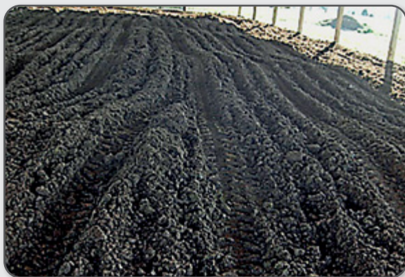
Figura 57 – Composto compactado pela utilização de trator pesado
