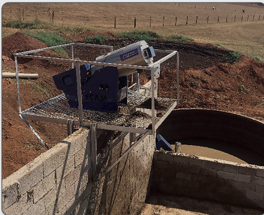
Figura 63 – Conjunto separador de sólidos instalado em plataforma.
