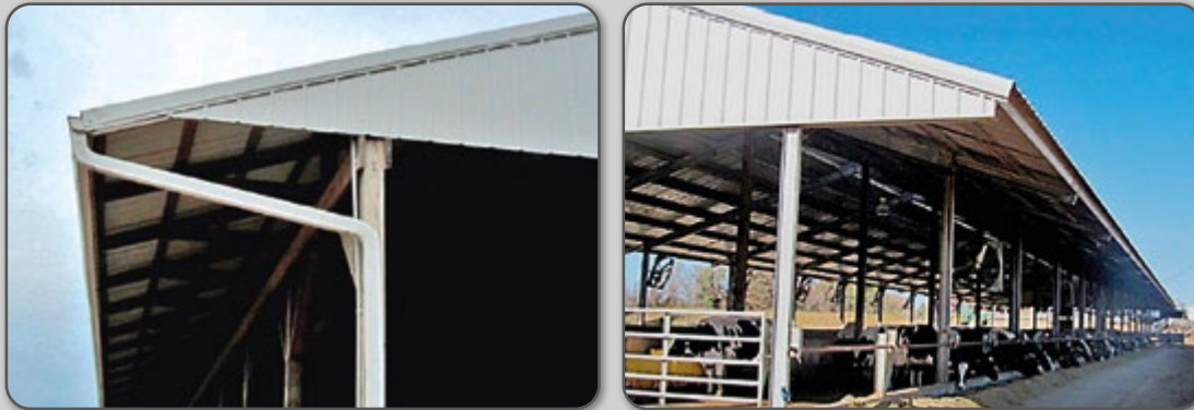
Figura 51 – Esquema do telhado do Compost Barn com calha e beiral.
