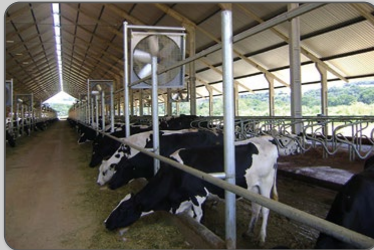
Figura 38 – Ventilação nos cochos, com aspersão.
