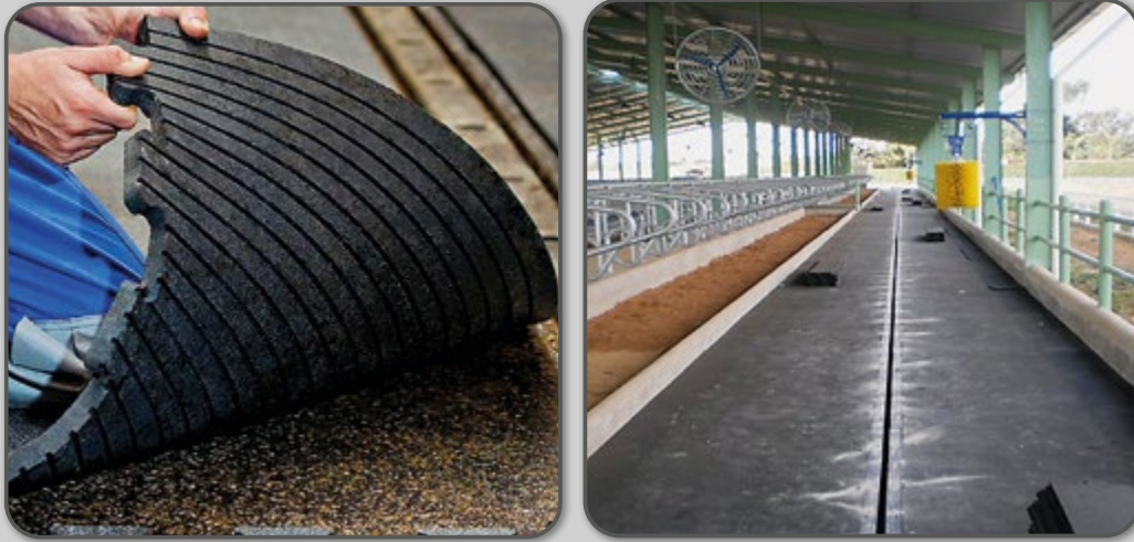
Figura 39 – Piso de borracha em galpão free stall .
