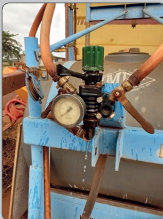
Figura 57 – Comando de pulverização com vazamento.
