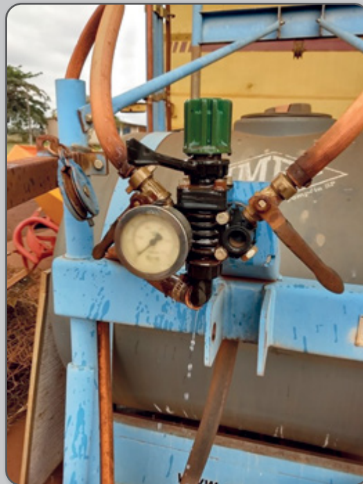
Figura 57 – Comando de pulverização com vazamento.
