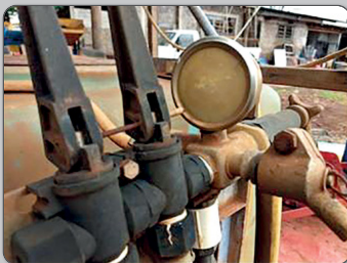
Figura 64 – Manômetro operacional e manômetro não operacional.
