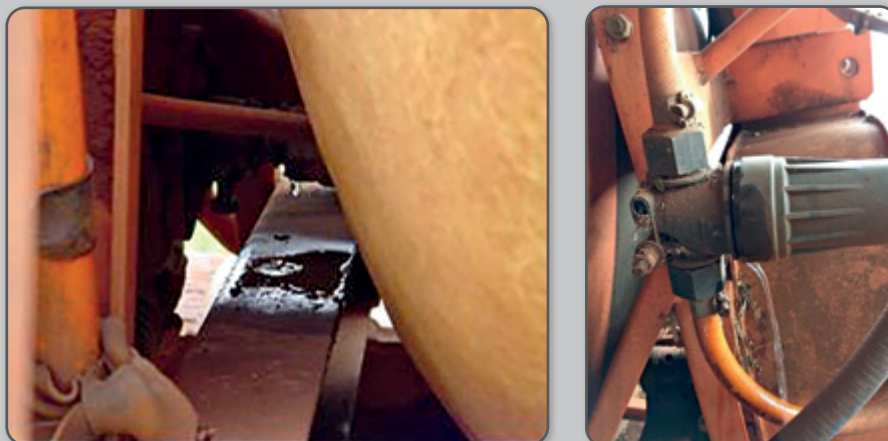
Figura 59 – Vazamentos no eixo do agitador mecânico e no filtro de linha.
