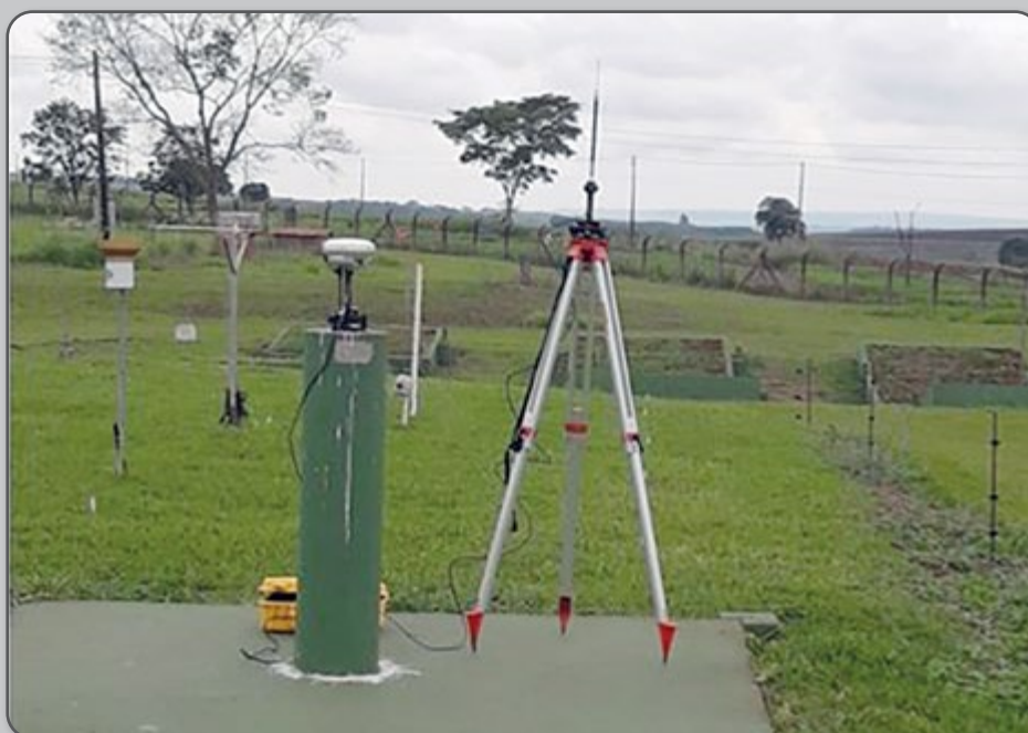
Figura 25 – Montagem correta da estação RTK.
