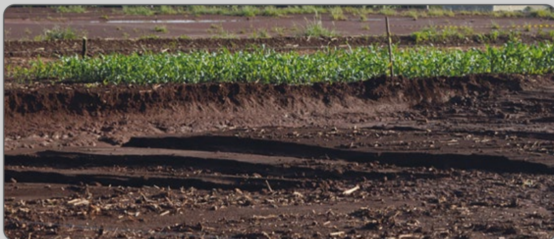
Figura 10 – Sulcos de erosão.
