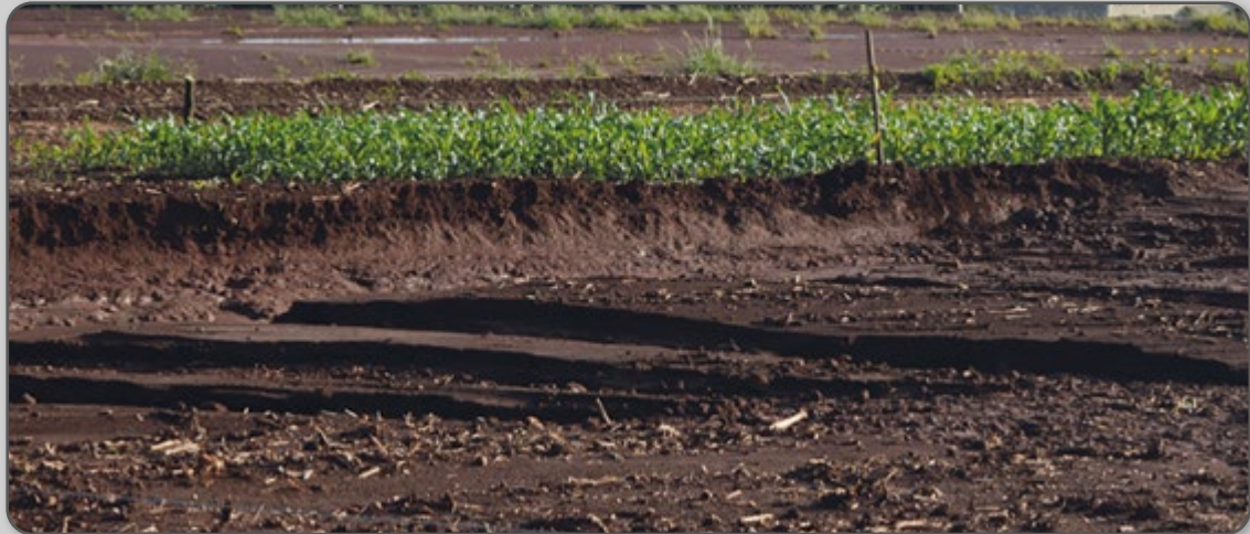
Figura 10 – Sulcos de erosão.
