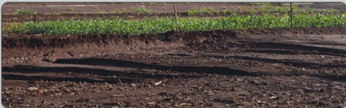
Figura 10 – Sulcos de erosão.
