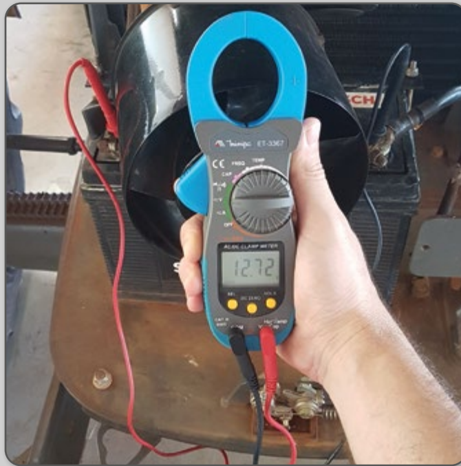
Figura 109 – Verificação da carga da bateria com multímetro.
