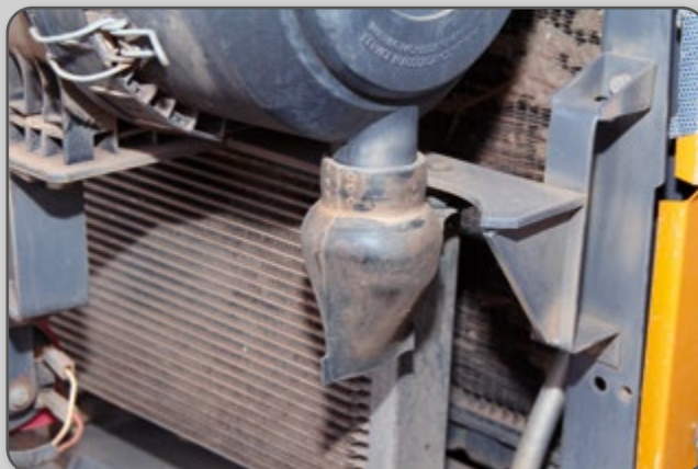
Figura 19 – Válvula de descarga do ejetor de poeira.
