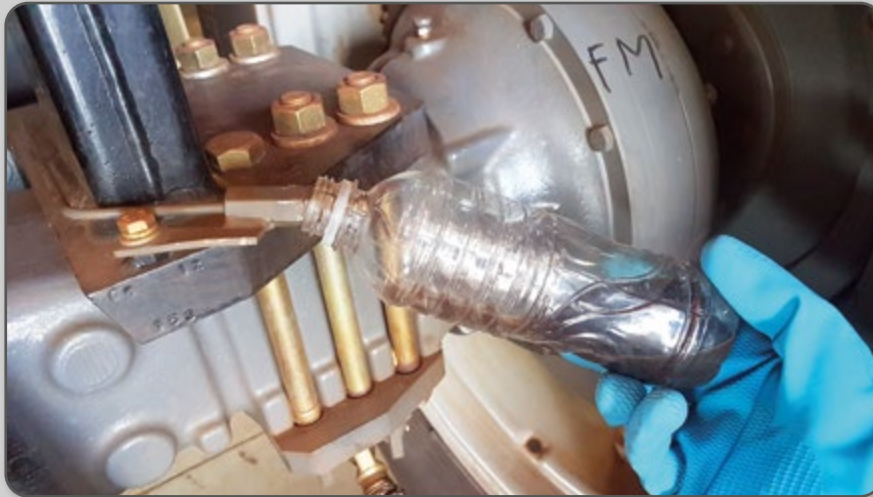
Figura 104 – Drenagem do fluido de freio.
