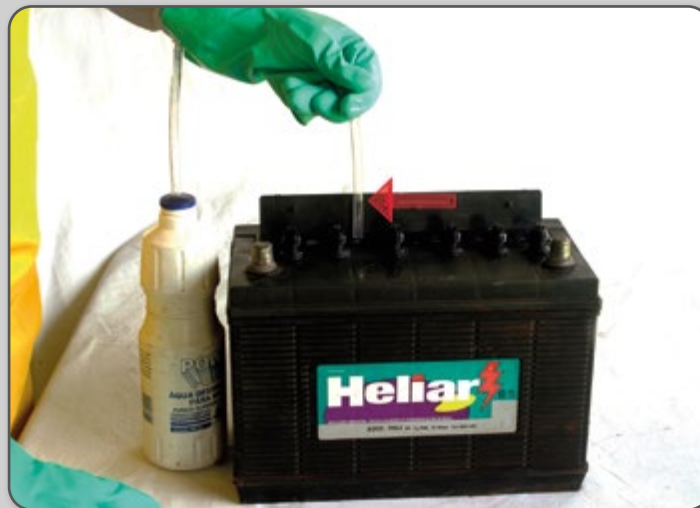
Figura 119 – Medição do nível da solução eletrolítica da bateria.
