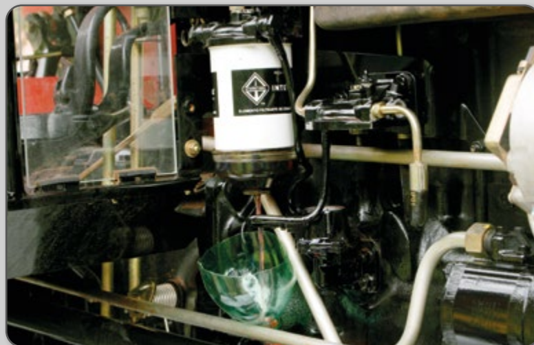
Figura 34 – Escoamento do diesel pelo bужão de drenagem inferior.
