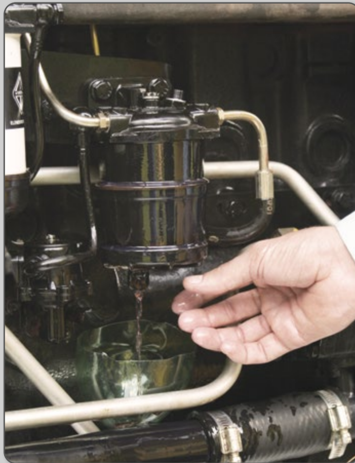
Figura 31 – Drenagem do copo sedimentador.
