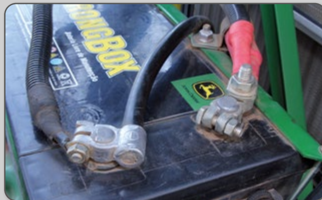
Figura 114 – Terminal e borne em boas condições.
