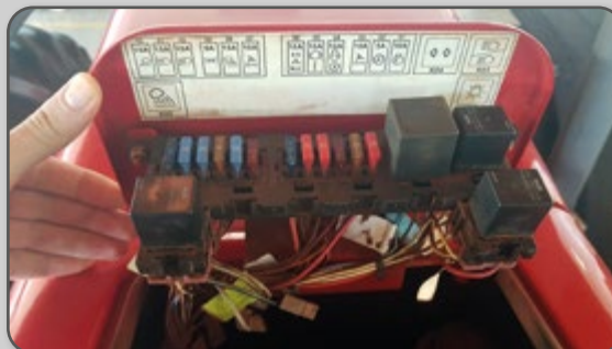
Figura 124 – Caixa de fusíveis.
