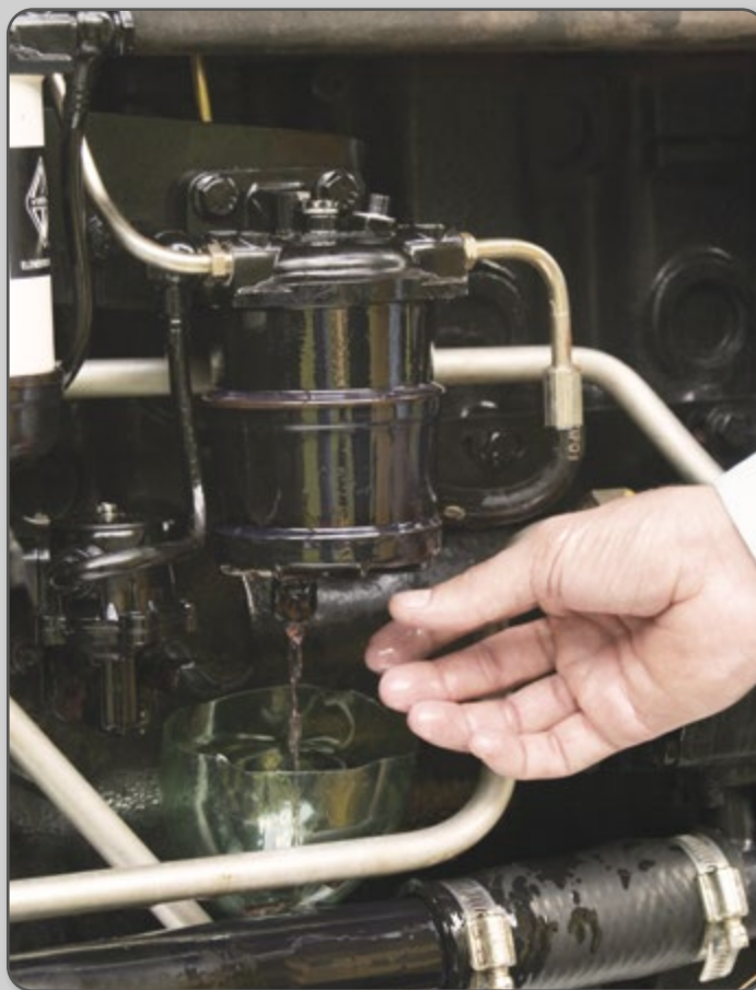
Figura 31 – Drenagem do copo sedimentador.
