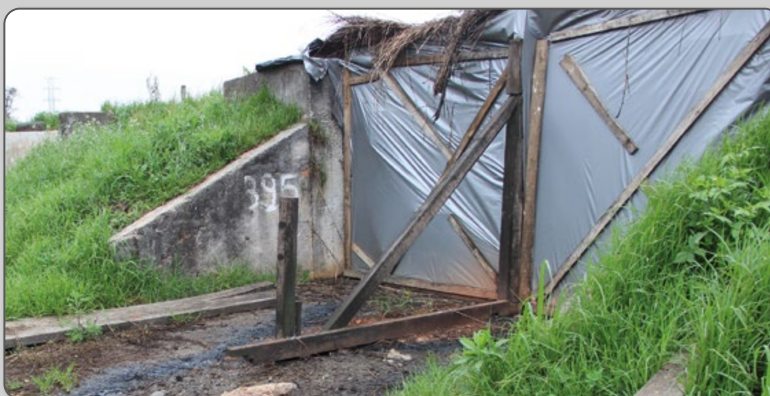
Figura 11 – Fechamento de silo trincheira com madeira.
