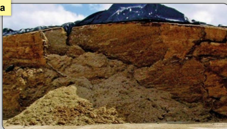
Figura 28 – Silo trincheira (a) e (b) silo superfície com desmoronamento.
