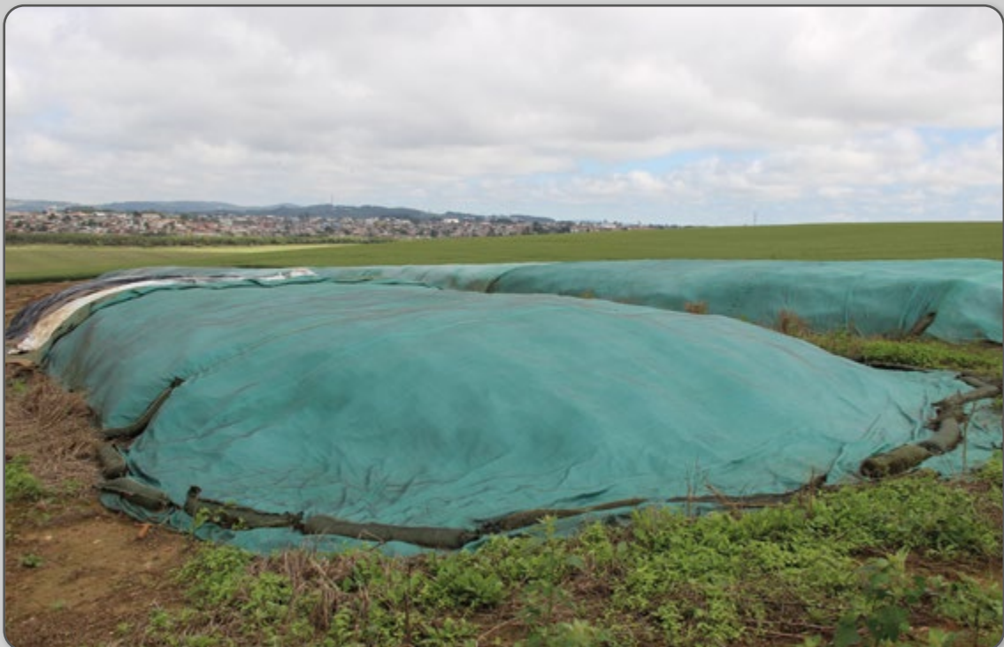
Figura 18 – Abaulamento necessário em silo trincheira.
