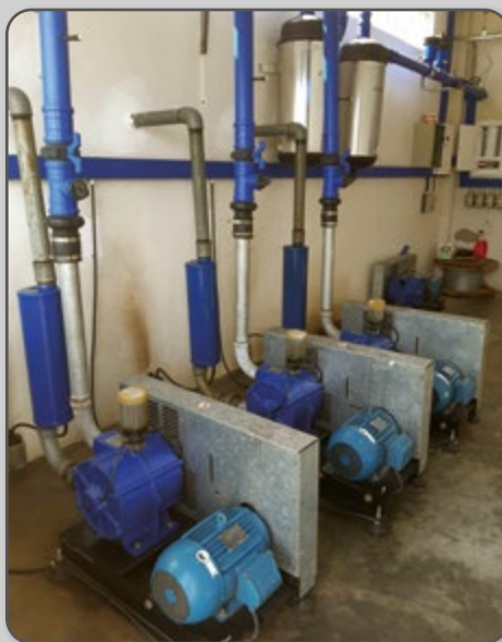
Figura 15 – Bomba de vácuo.
