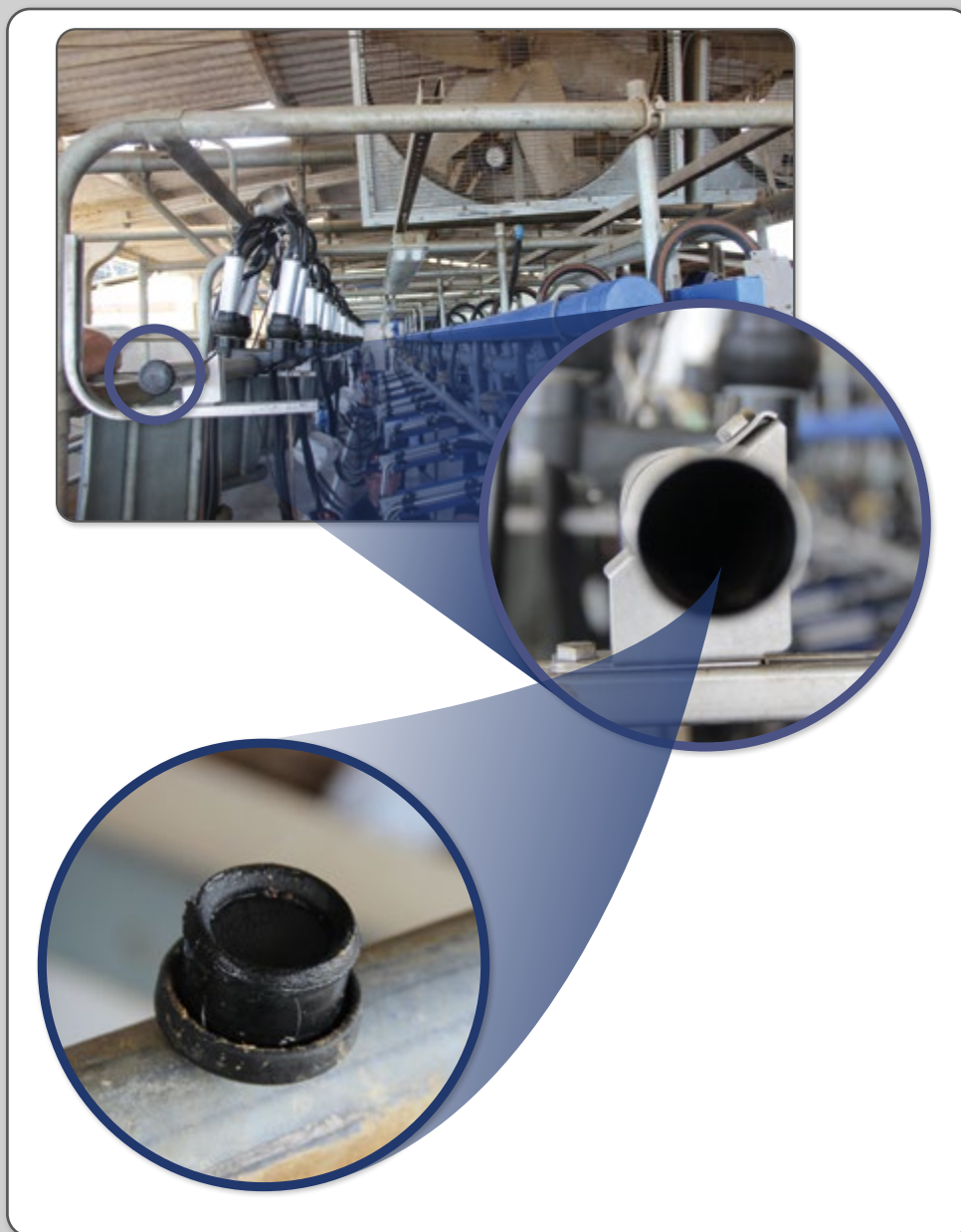
Figura 59 – Inspeção na limpeza do equipamento.
