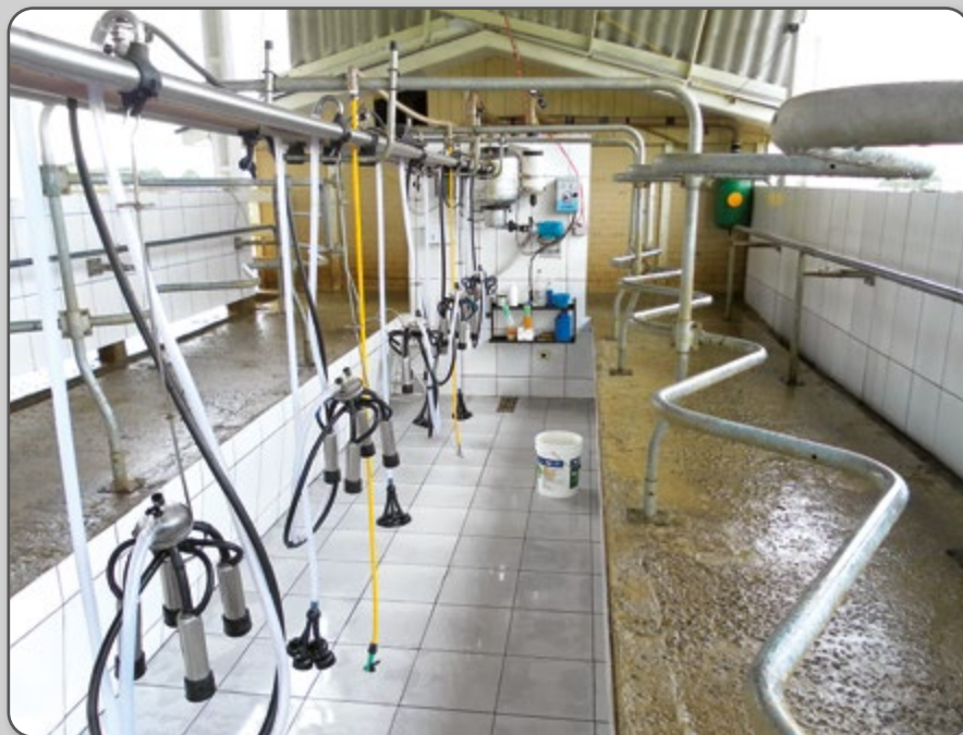
Figura 25 – Tubulação de leite.
