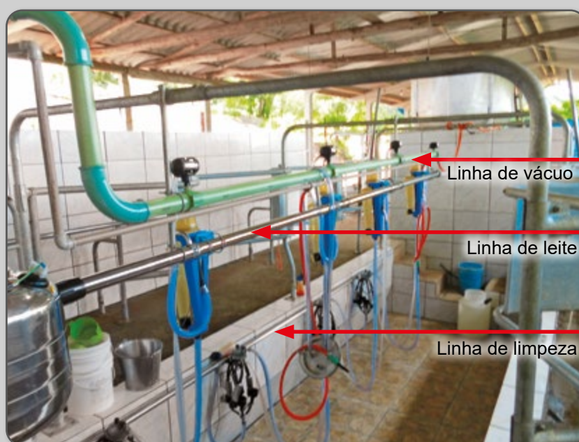
Figura 21 – Tipos de tubulação.
