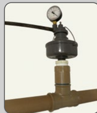
Figura 30 – Regulador do tipo servo assistido.
