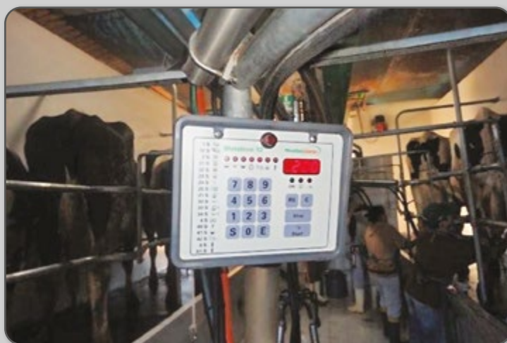
Figura 52 – Painel controlador do medidor de leite.
