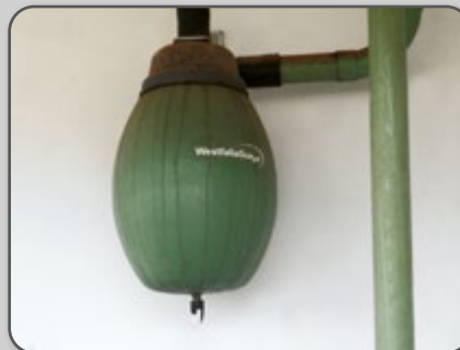
Figura 19 – Depósito de segurança.
