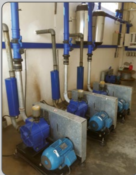
Figura 15 – Bomba de vácuo.
