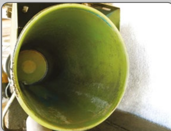
Figura 58 – Falha na limpeza do equipamento.
