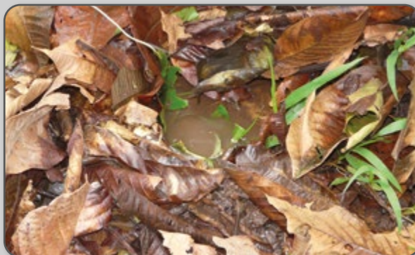
Figura 18 – Local com encharcamento.
