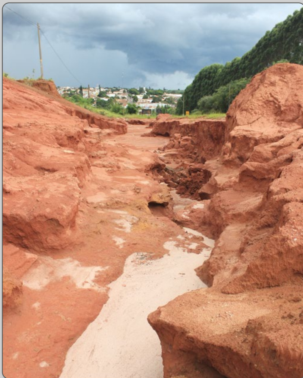
Figura 128 – Erosão em área de solo vulnerável.
