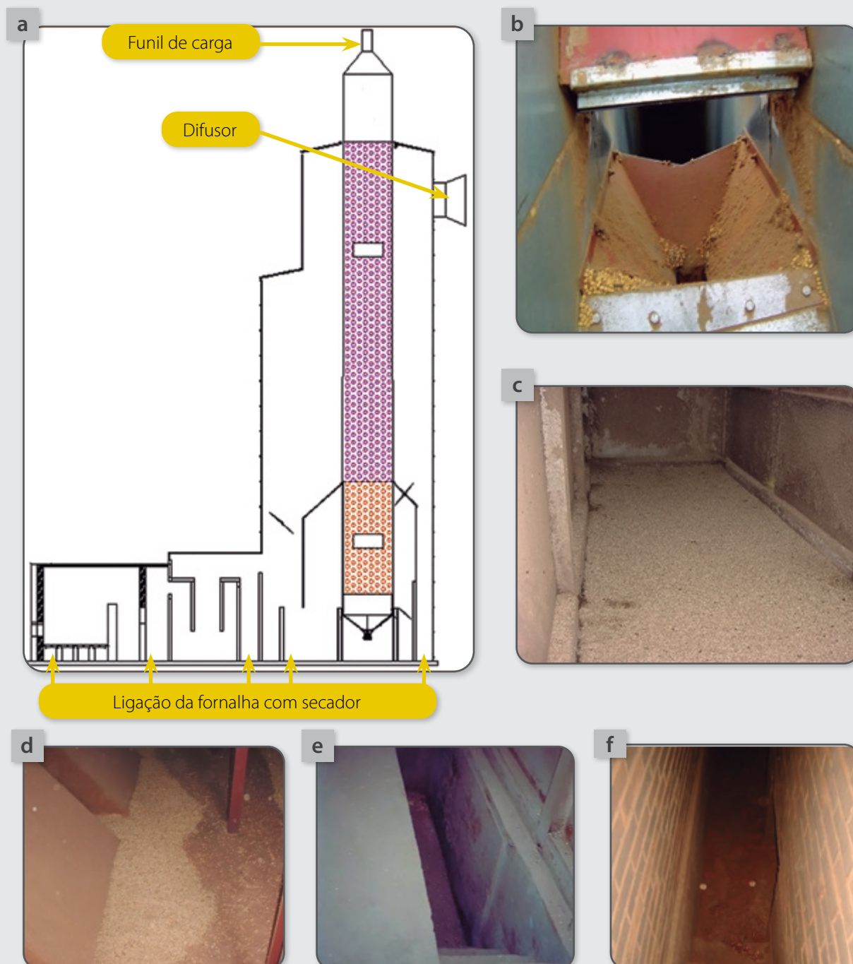
Figura 52 – Locais que devem ser limpos diariamente : indicação dos locais (a); funil de carga (b); parte interna dos difusores (c); ligação fornalha com secador (d, e, f).
