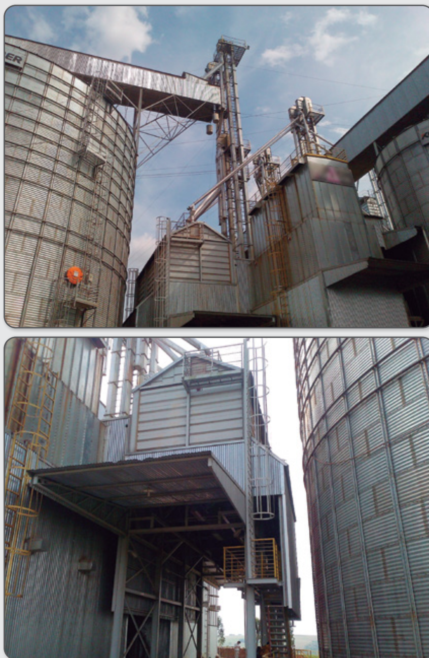
Figura 110 – Exemplo típico de tulha de expedição metálica.
