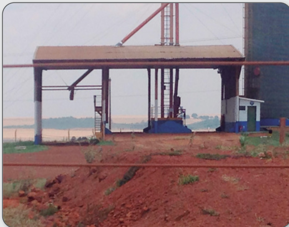
Figura 109 – Exemplo típico de unidade com sistema de expedição direta, do elevador para caminhão.
