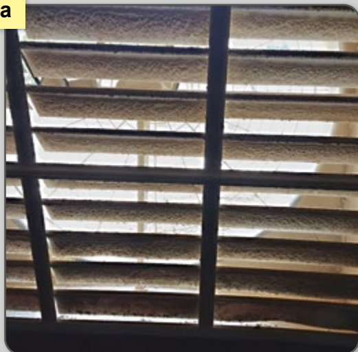
Figura 32 – Exaustores com (a) sujeira acumulada e (b) aletas danificadas
