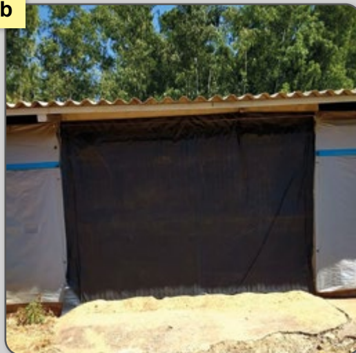
Figura 50 – (a) Portão com boa vedação e (b) portão com lona externa para ajudar na vedação.
