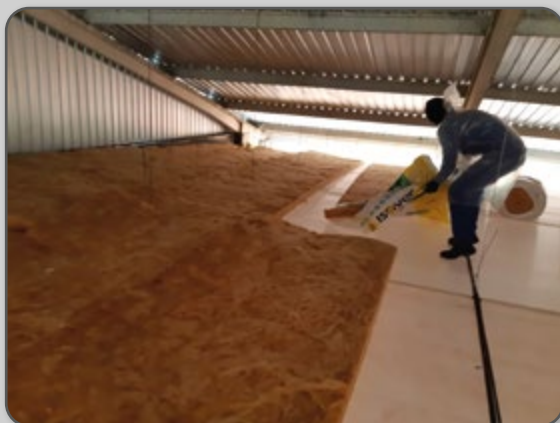
Figura 51 – Instalação de lã de vidro sobre a forração.
