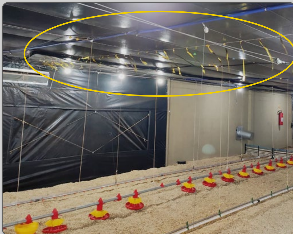
Figura 26 – Fitinhas fixas no teto do aviário para identificar o percurso do ar entrando pelos inlets .
