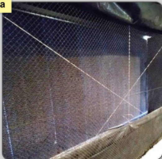
Figura 38 – Entrada de ar do túnel door , (a) cortina e (b) janelão.
