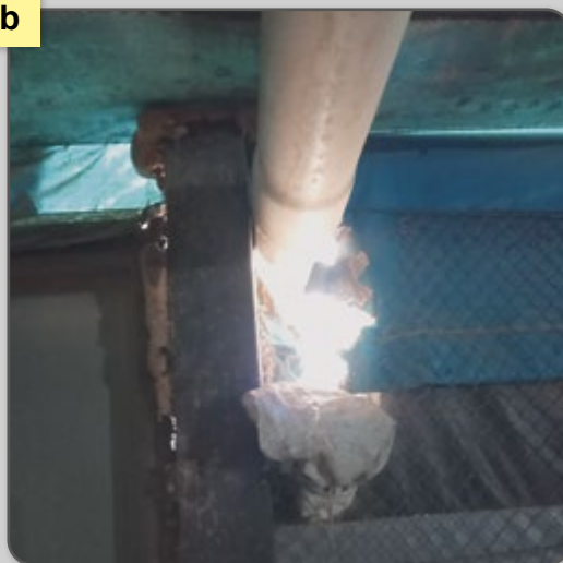
Figura 47 – Falhas de vedação: (a) portão mal vedado, (b) cortina rasgada, (c) porta mal vedada e (d) portão mal vedado.
