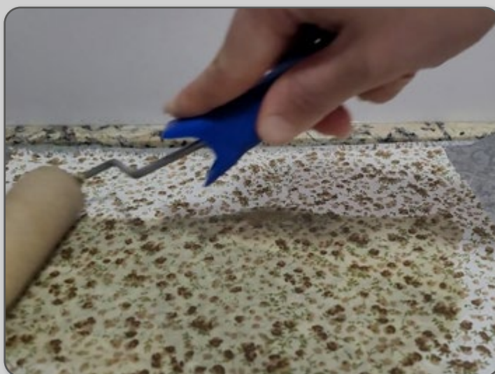
Figura 88 – Espalhamento das ceras e da resina com o rolo de pintura.
