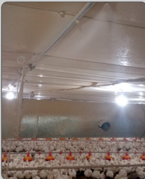
Figura 74 – Nebulizador em funcionamento.
