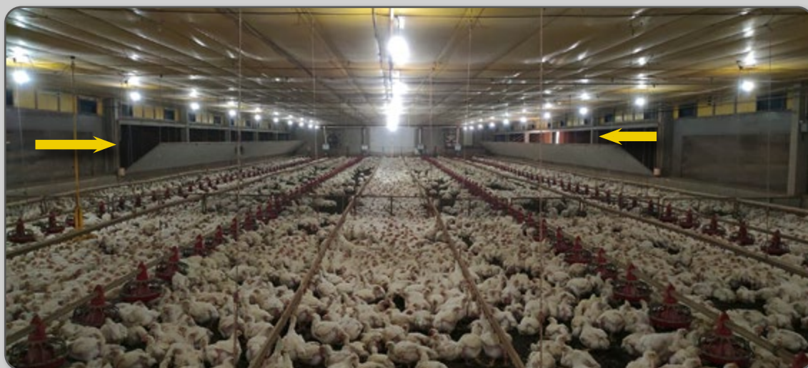
Figura 63 – Ventilação túnel. Inlets fechados, túnel door aberto.
