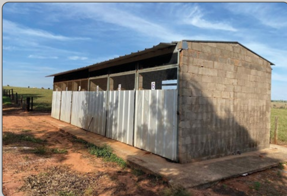
Figura 18 – Barracão de compostagem.
