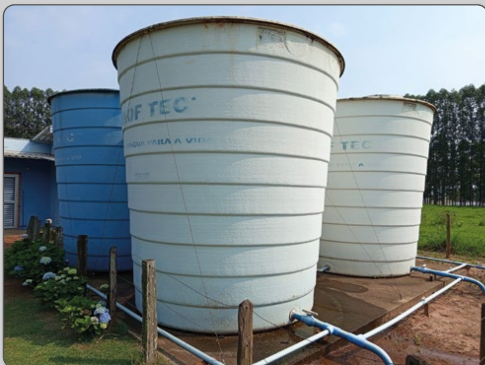
Figura 77 – Reservatório de água.
