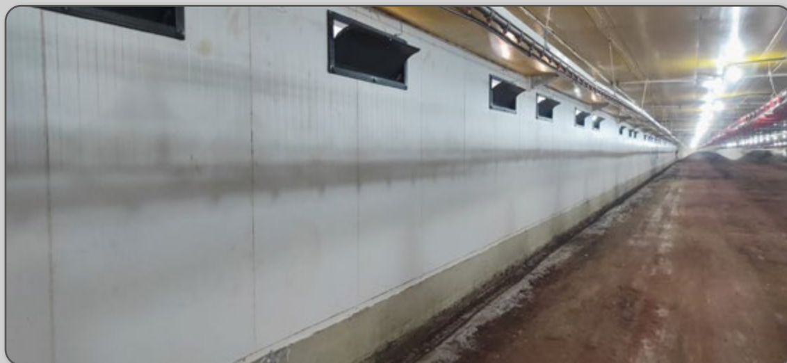
Figura 45 – Aviário com parede de isopainel.
