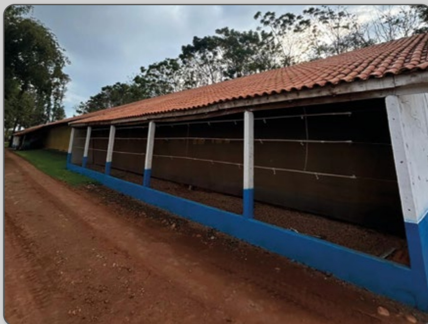
Figura 37 – Aviário pressão negativa convencional.
