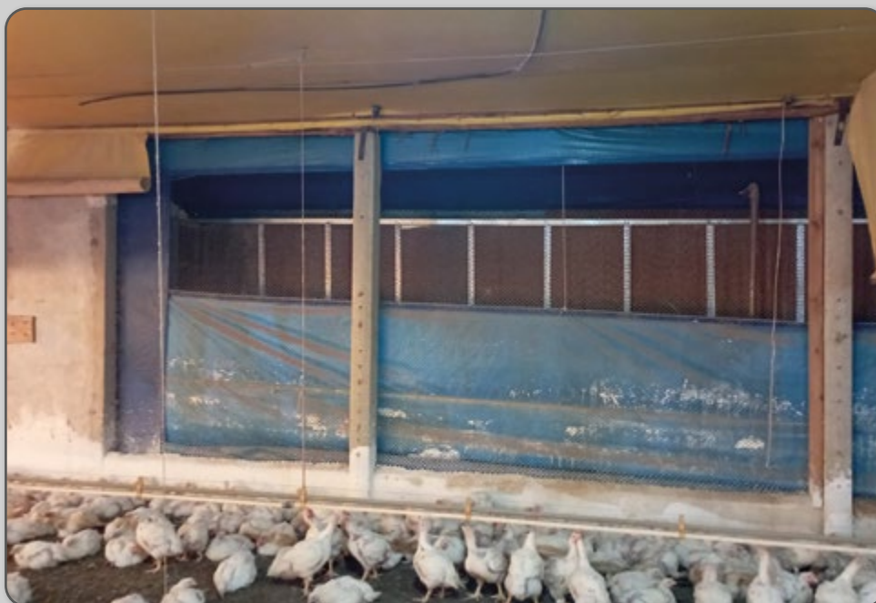
Figura 53 – Entrada de ar frontal controlada por cortina.
