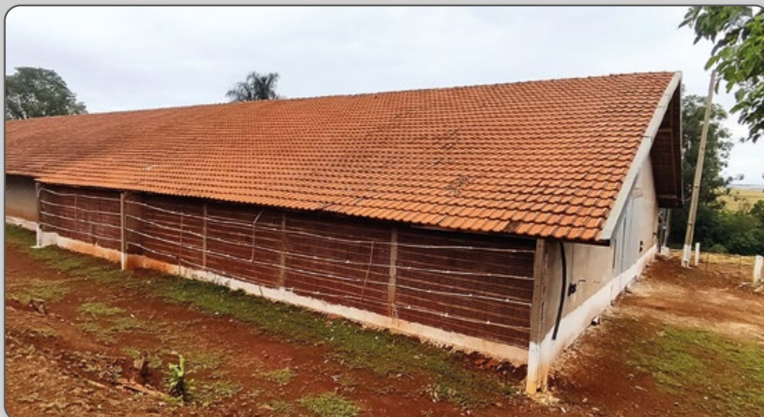
Figura 69 – Entrada de ar com tijolo vazado.
