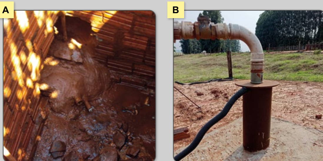
Figura 75 – A) Nascente protegida; B) Poço artesiano-.
