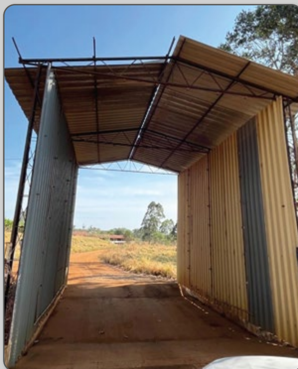
Figura 15 – Arco de desinfecção.
