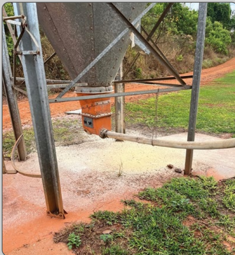
Figura 27 – Silos sujos na parte externa.
