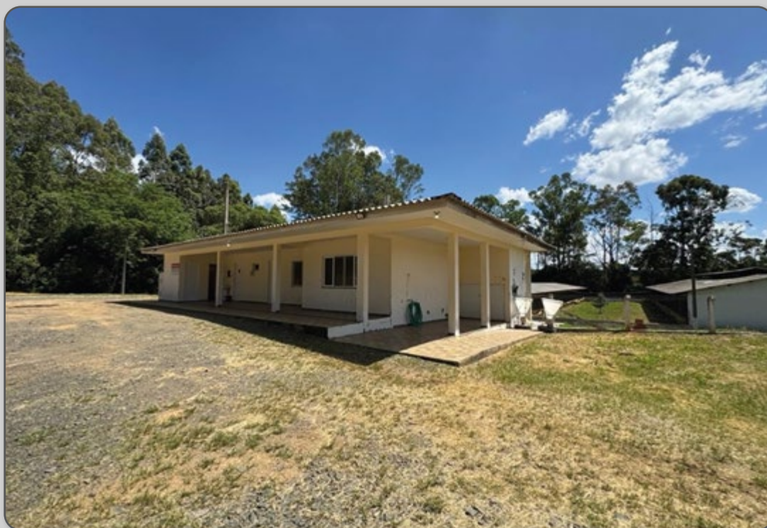
Figura 8 – Escritório anexo à cerca perimetral.
