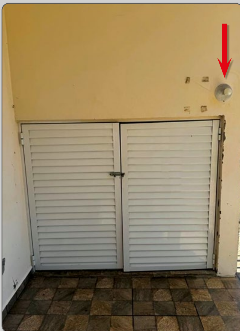
Figura 11 – Parte externa do fumigador com lâmpada para indicar funcionamento.
