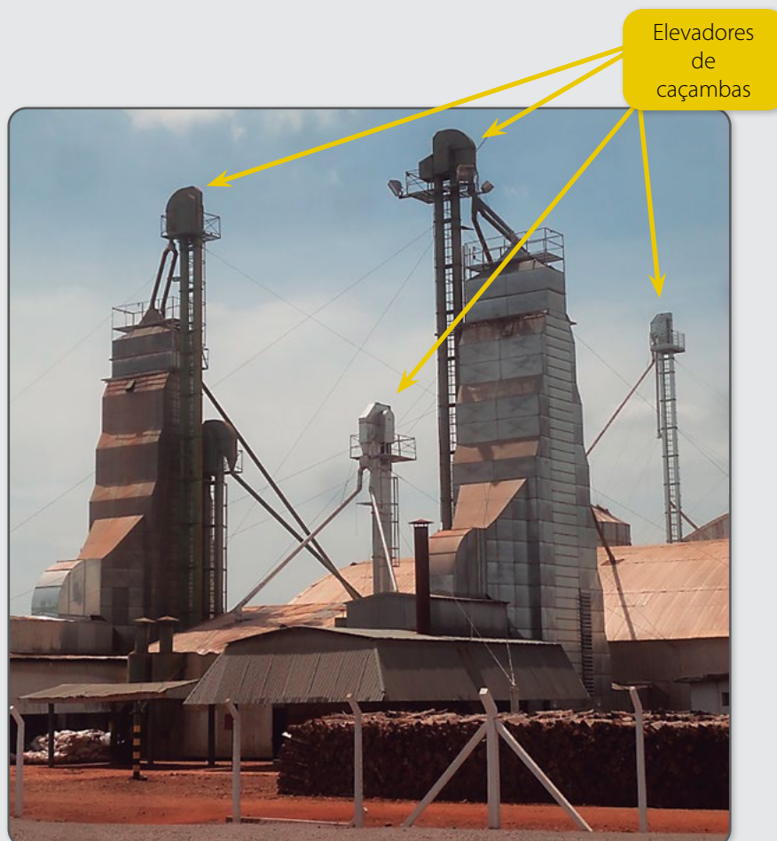
Figura 55 – Unidade típica de armazenagem de grãos.
