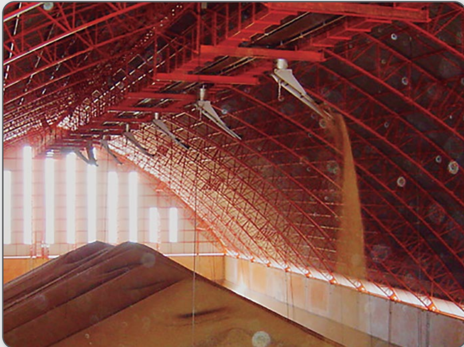
Figura 84 – Correia transportadora abastecendo armazém.
