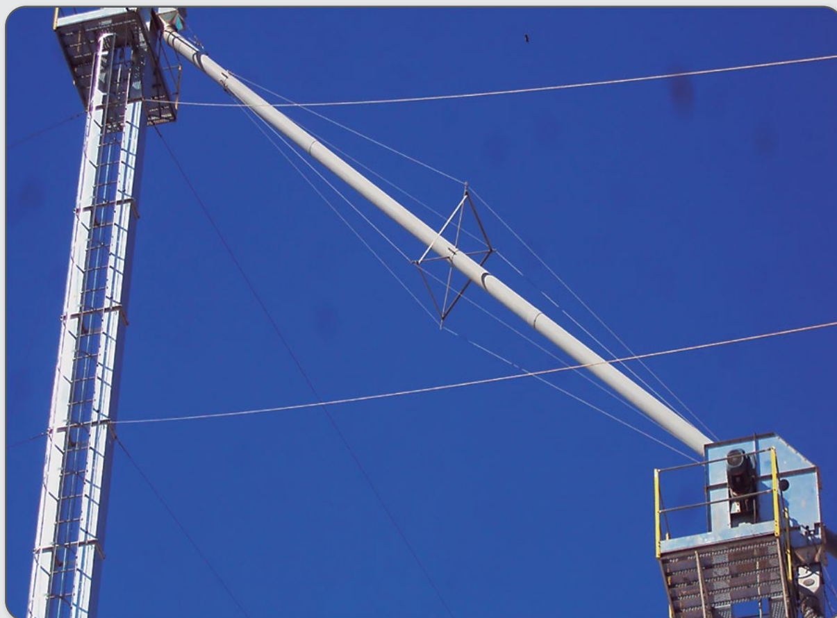
Figura 37 – Detalhes de canalizações de grãos.
