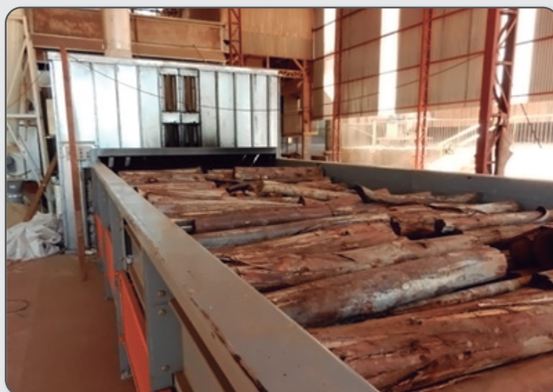
Figura 51 – Alimentador de lenha automatizado.
