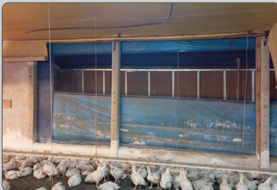
Figura 53 – Entrada de ar frontal controlada por cortina.
