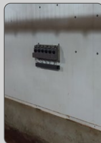
Figura 87 – Termostato mecânico de segurança.
