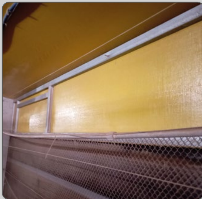
Figura 46 – Forração: transpasse e dobra externa.
