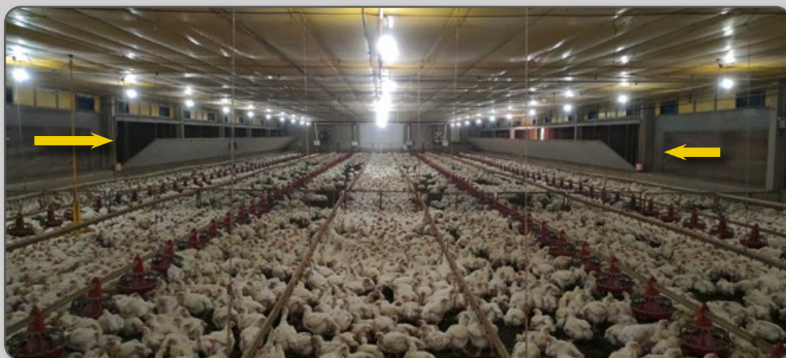
Figura 63 – Ventilação túnel. Inlets fechados, túnel door aberto.
