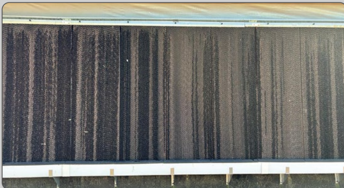
Figura 72 – Sistema de irrigação da placa evaporativa entupido.
