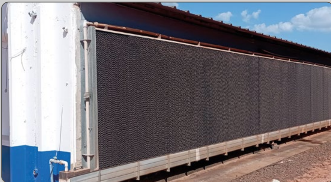
Figura 70 – Entrada de ar com placa evaporativa.
