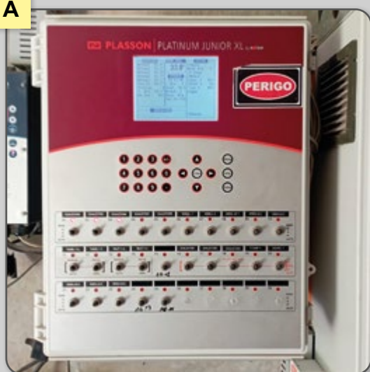
Figura 42 – Controladores de ambiente: A) PLASSON; B) INOBRAN; C) Chore-Time; D) GSI.
