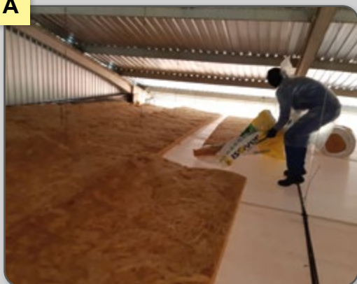
Figura 41 – Lã de vidro sobre a forração do galpão.
