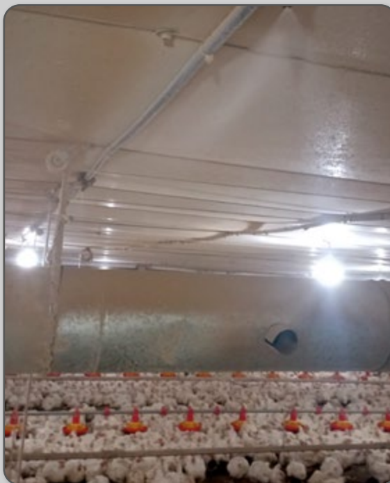
Figura 74 – Nebulizador em funcionamento.
