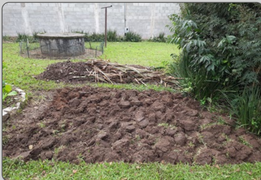
Figura 31 – Remoção de gramado e descompactação de solo.
