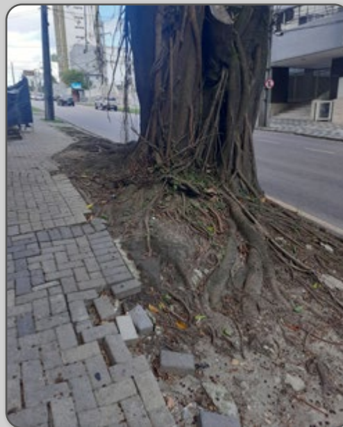
Figura 24 – Exemplo de Ficus sp. com raízes agressivas que danificam o calçamento.
