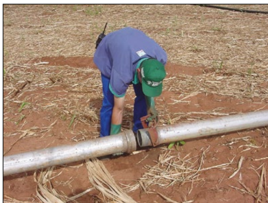
Conexão com tubulação de alumínio
