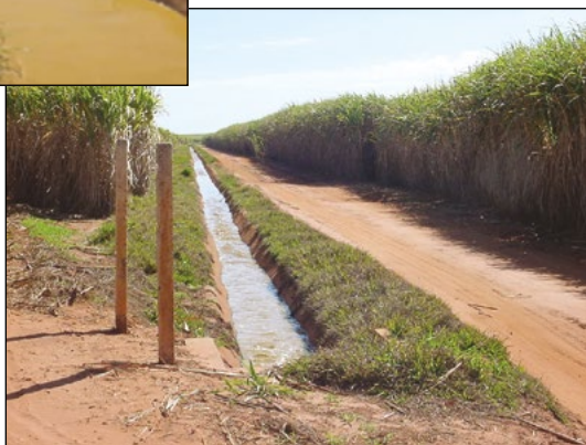
Canais revestidos por manta asfáltica
