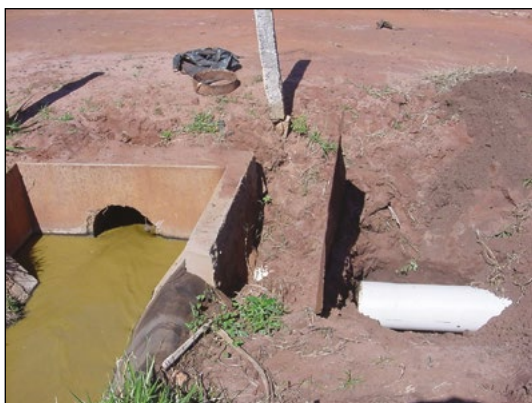
Conexão do canal com tubulação de PVC
