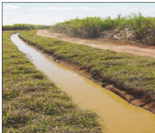
Canais revestidos por manta asfáltica
