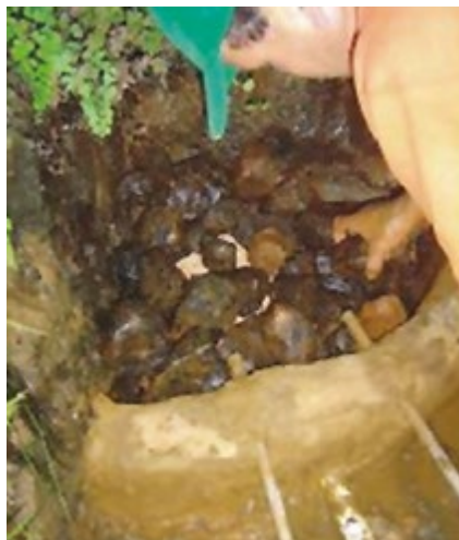
Figura 118 – Deposição de areia recoberta por camada de pedra britada.
