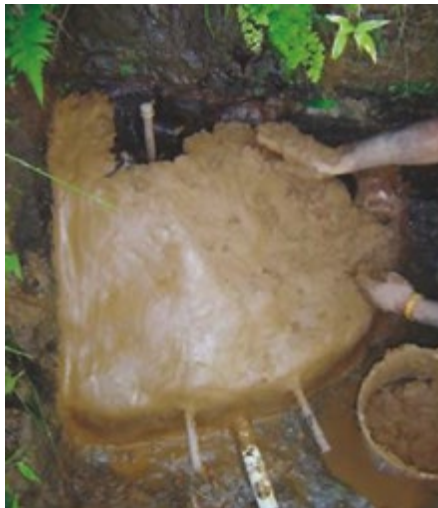
Figura 119 – Etapa final de proteção de fonte.
