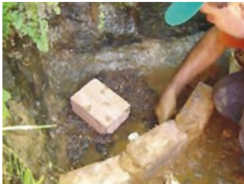
Figura 117 – Construção de parede para proteção de fonte.
