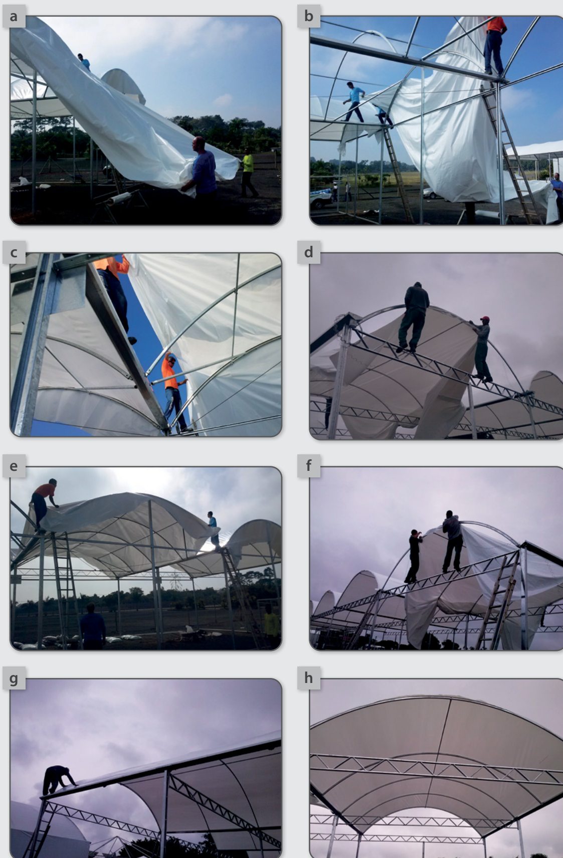
Figura 7 – Abertura do filme plástico (a); início da aplicação (b); cuidados com o primeiro arco (c); fixação frontal (d); fixação frontal (e) e (f); fixação lateral (g); estufa coberta (h).
