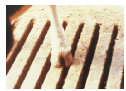
Piso mal dimensionado
